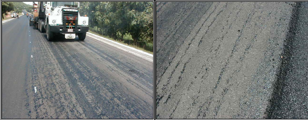
Fotografías No.1 y No.2 : Fotografías del riego de liga asfáltica utilizado en las cercanías de la estación 2+000.
