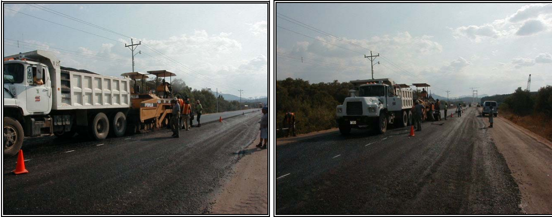
Fotografías No.6 y No.7: Utilización de “traba” en las cercanías del Puente sobre el Río Tempisque.
