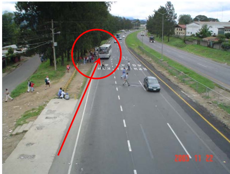
Fotografía 2: El traslado de la parada de autobús estimula a que el peatón cruce la autopista directamente y no utilice el puente peatonal existente.
