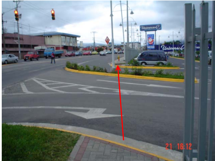
Fotografía 11: El acceso a Multiplaza del Este cortó el movimiento normal de los peatones en la acera correspondiente, por lo que no existe demarcación de zona peatonal.
