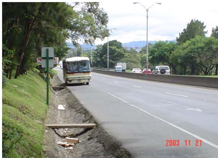
Fotografía 7: Ubicación de una parada de autobús, sobre el espaldón de la autopista, sin las facilidades requeridas para la seguridad del peatón.
