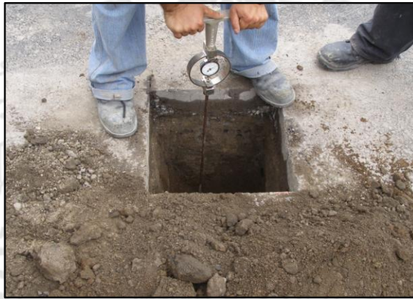
Figura 32. Prueba de CBR en sitio.
