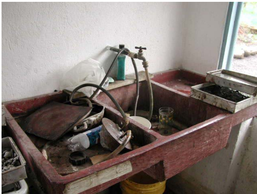
Fotografía 12: Estado en que se mantiene la pila de lavado de equipo
