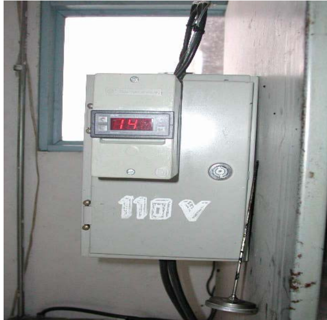
Fotografía 15: Detalle del sensor de temperatura y termómetro
