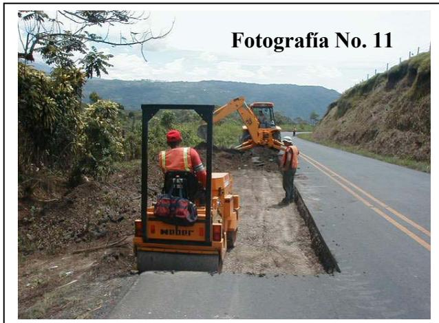
El material de base y sub-base dañado es sustituido por completo por un nuevo material granular hasta el nivel adecuado para la colocación de la mezcla asfáltica.
