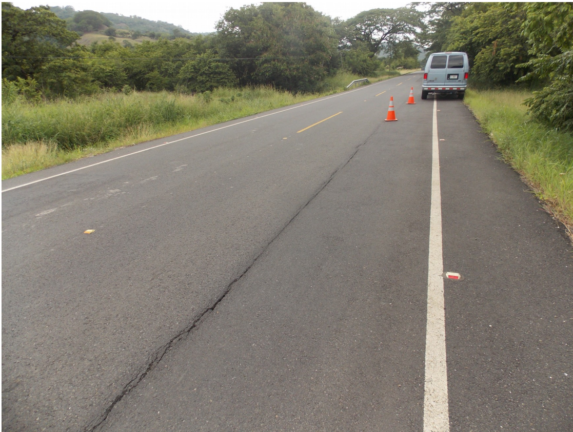
Figura 5: Agrietamiento longitudinal, est. 5+315
