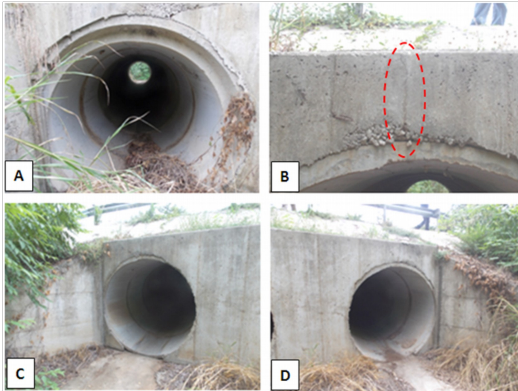
Figura 23: Alcantarilla en el est. 4+970, con obstrucción parcial de la tubería en la entrada (A), la grieta en el cabezal de salida (B), y las tuberías en el cabezal de salida (C & D).
