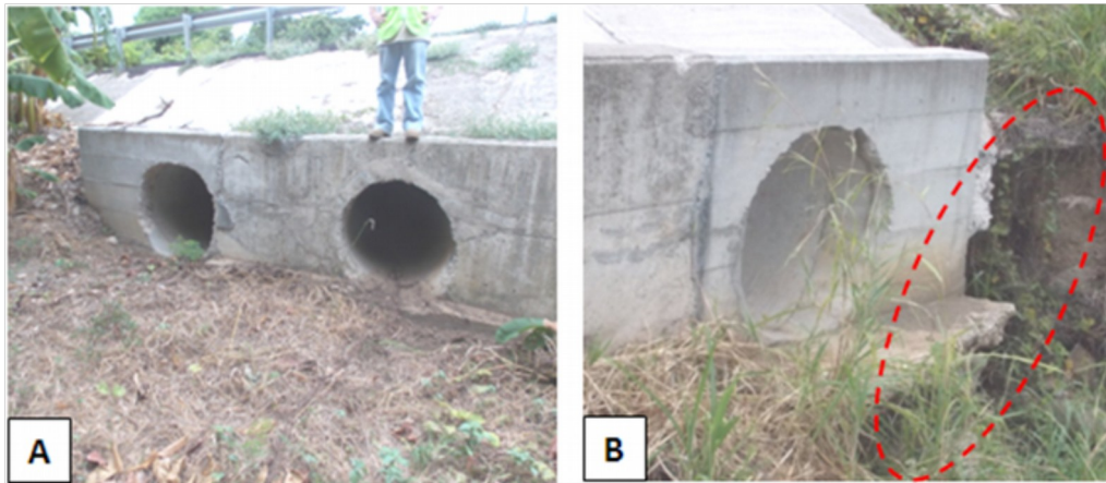
Figura 11: Vista del cabezal de entrada (A) y de la salida (B), donde se señala en rojo la zona que presenta socavación. Alcantarilla del est. 1+000.
