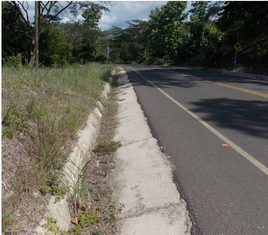
Figura 9: Estado de las cunetas, est. 9+700.
