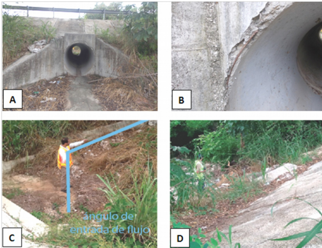
Figura 24: Alcantarilla en el est. 5+275, vista del cabezal de salida (A), donde se da el desprendimiento de concreto (B). Acumulación de basura a la entrada (C) y salida (D).
