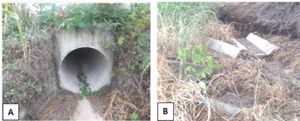
Figura 25: Vista desde la salida (A) y cauce en la entrada (B), alcantarilla en 5+880.
