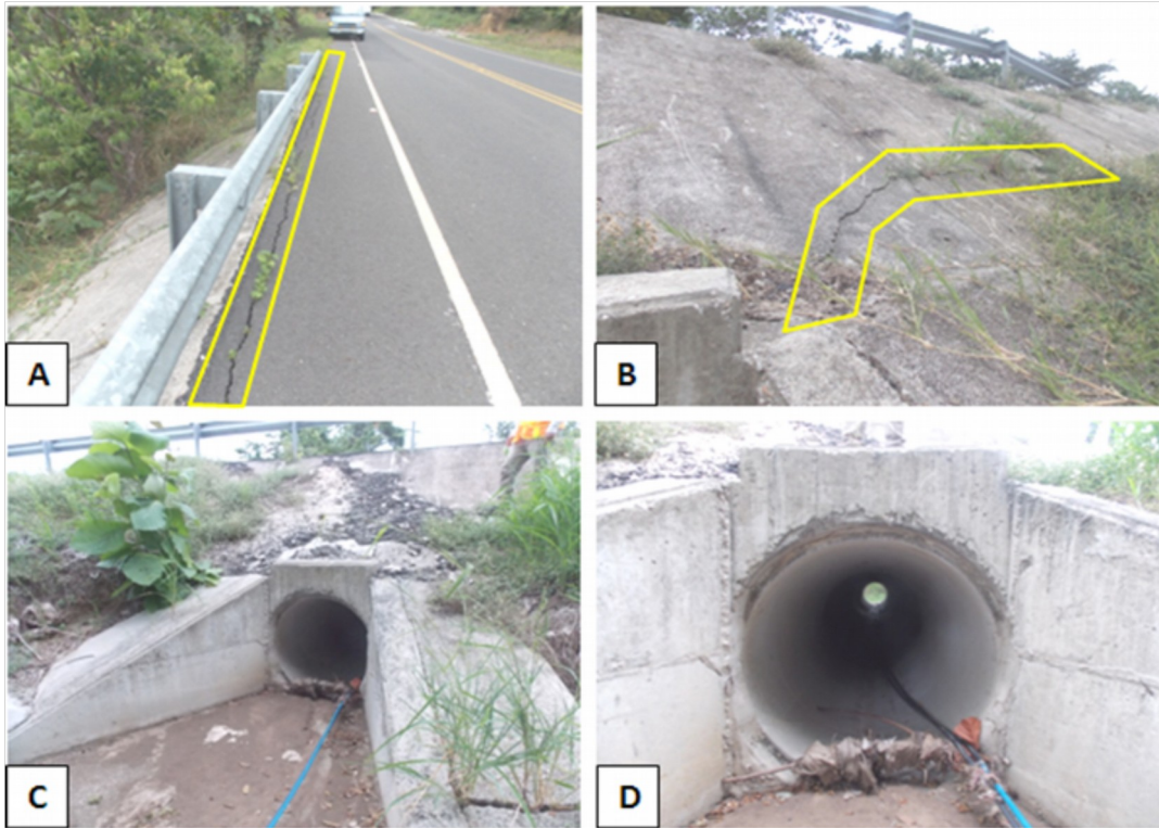
Figura 12: Alcantarilla en el est. 1+500, mostrando la grieta en la carpeta asfáltica (A) y en el talud sobre la salida (B); vista del cabezal de entrada (C) y de la tubería (D).
