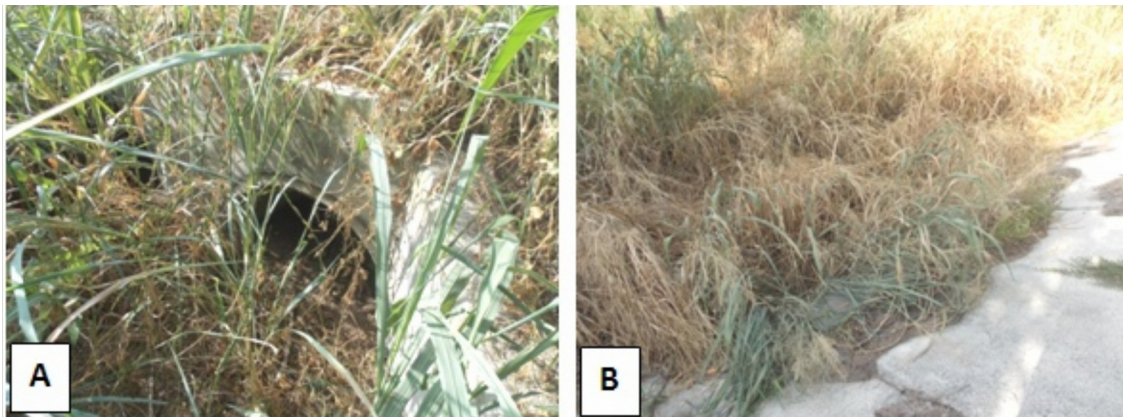
Figura 27: Vista de la entrada (A) y salida (B), alcantarilla en el est. 6+595.
