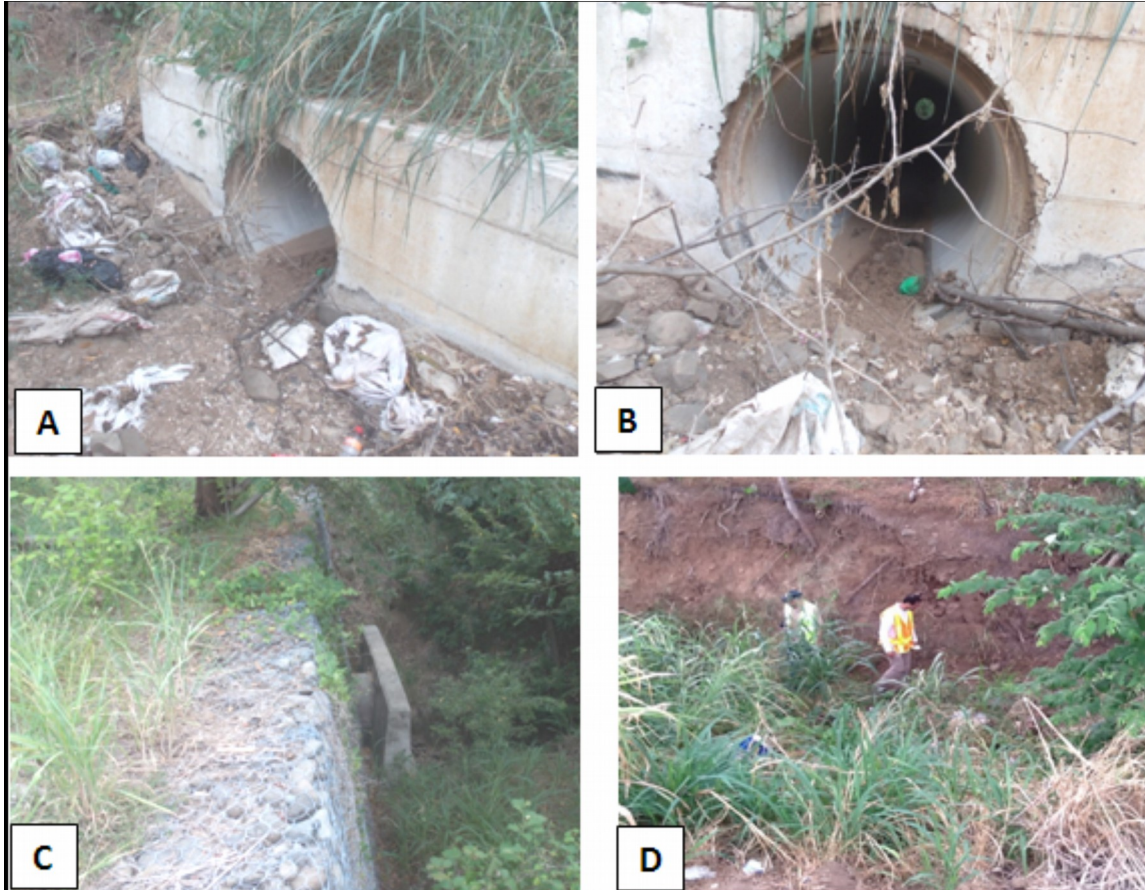
Figura 14: Alcantarilla en el est. 2+485, mostrando la entrada (A), la tubería (B), el muro de gaviones en el talud sobre el cabezal de la salida (C) y el cauce del río con gran cantidad de sedimentos, vegetación y basura (D).
