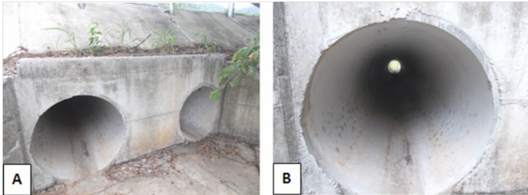
Figura 19: Vista del cabezal de salida (A) y de la tubería (B), alcantarilla del est. 3+905.
