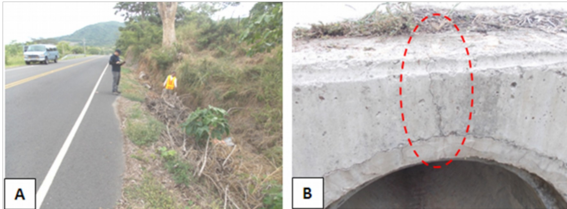
Figura 15: Vista a nivel de carpeta (A) y grieta en el cabezal de salida (B), alcantarilla del est. 2+665.
