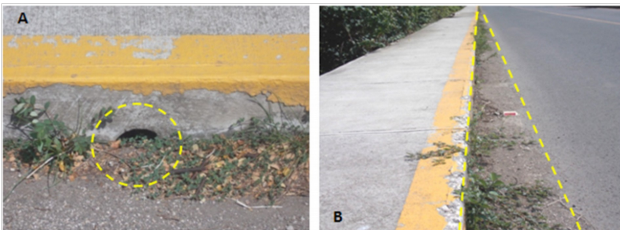
Figura 33: Sistema de drenaje, poblado de Lepanto, donde se muestran las salidas obstruidas (A) debido a la acumulación de sedimento y maleza (B).
