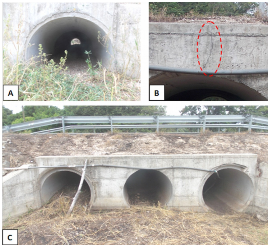
Figura 20: Vista del cabezal de salida (A) y de la tubería (B), alcantarilla del est. 3+905.
