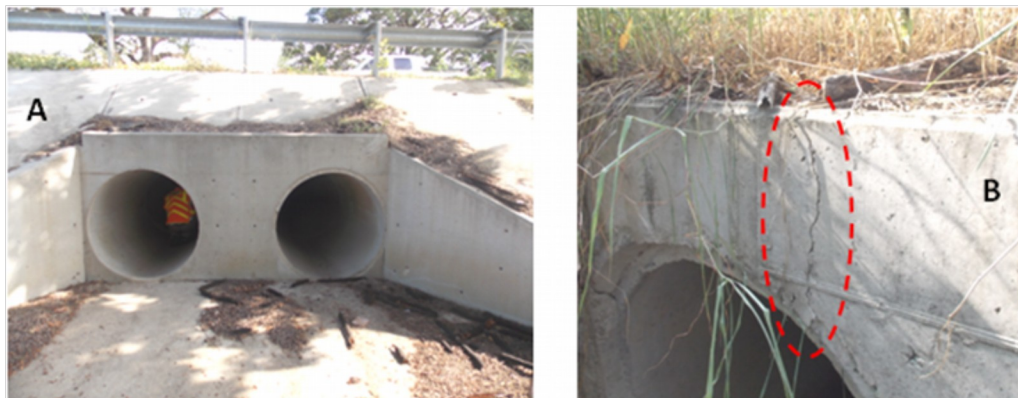
Figura 30: Vista de la salida (A) y de la grieta en la entrada (B), alcantarilla en el est. 7+425.
