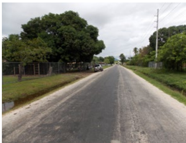
Figura 5. Aplicación de melaza (izquierda) y sellos asfálticos (derecha) para control de polvo.
