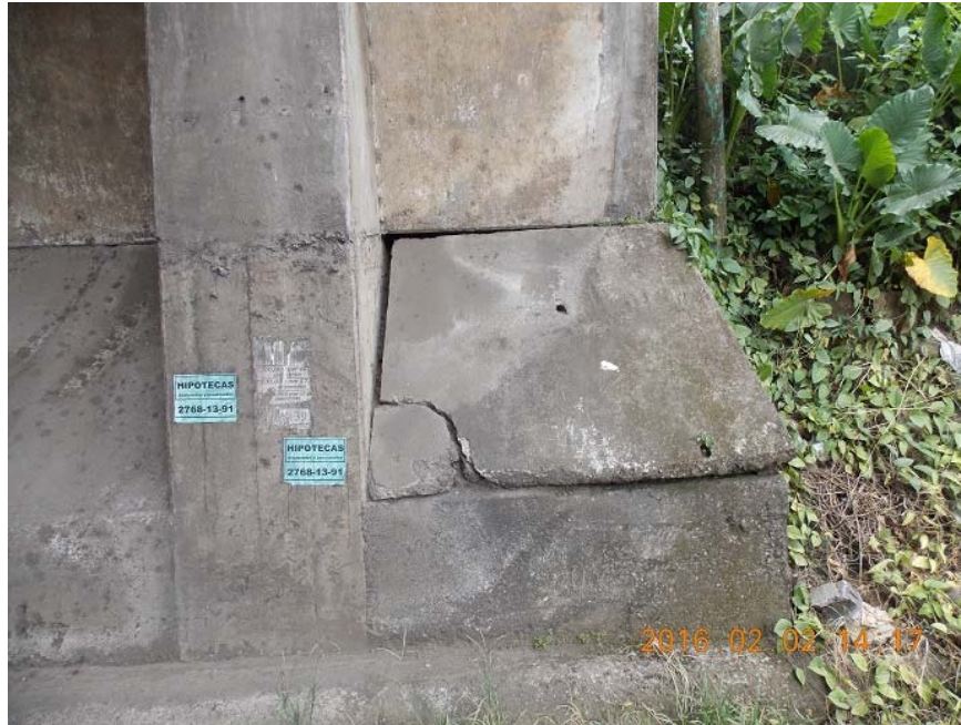
Figura 11. Agrietamiento y desprendimiento de la protección del talud frente al bastión 1.
