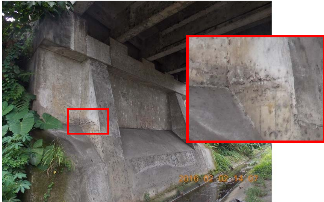
Figura 9. Nidos de piedra en columna del bastión 1.
