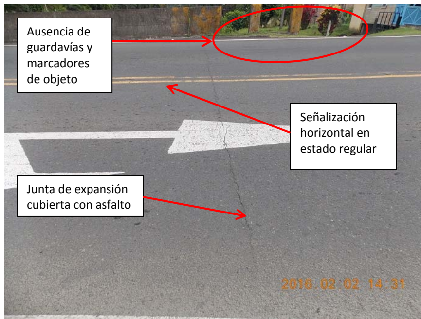
Figura 3. Ausencia de guardavías y marcadores de objeto, junta de expansión del acceso 2 cubierta con asfalto y demarcación horizontal en estado regular.
