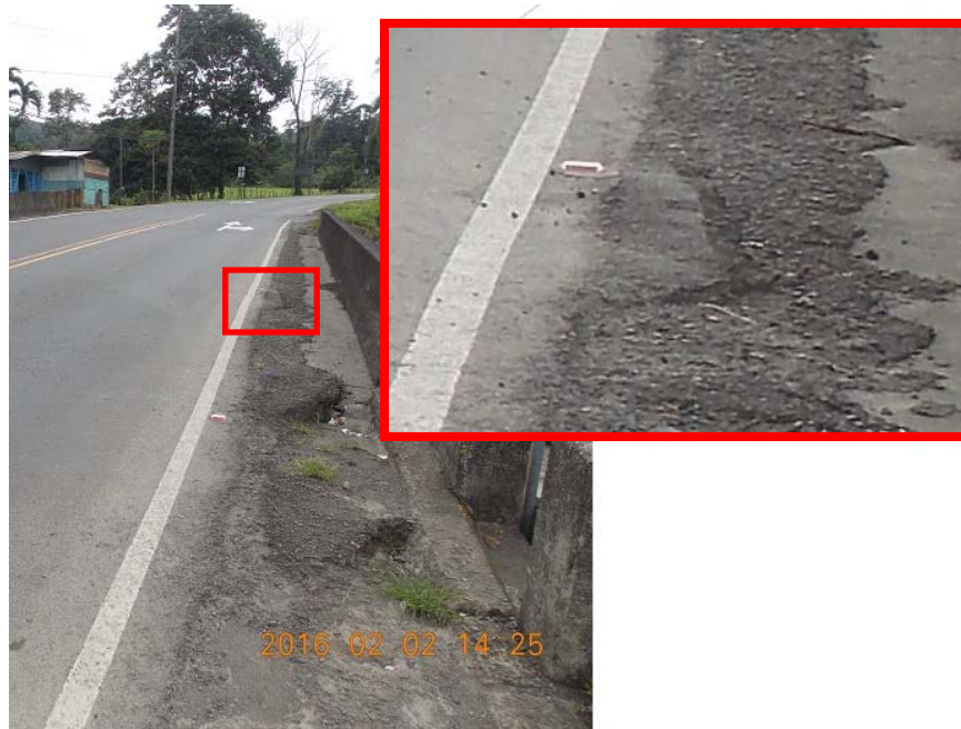
Figura 5. Sobrecapas de asfalto sobre la superestructura.
