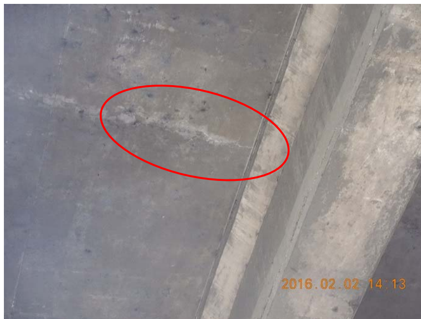
Figura 6. Eflorescencia en la cara inferior del tablero.
