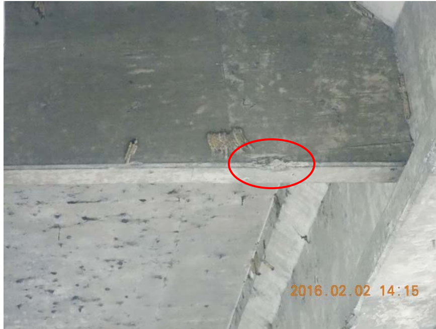
Figura 7. Nidos de piedra puntuales en viga diafragma.
