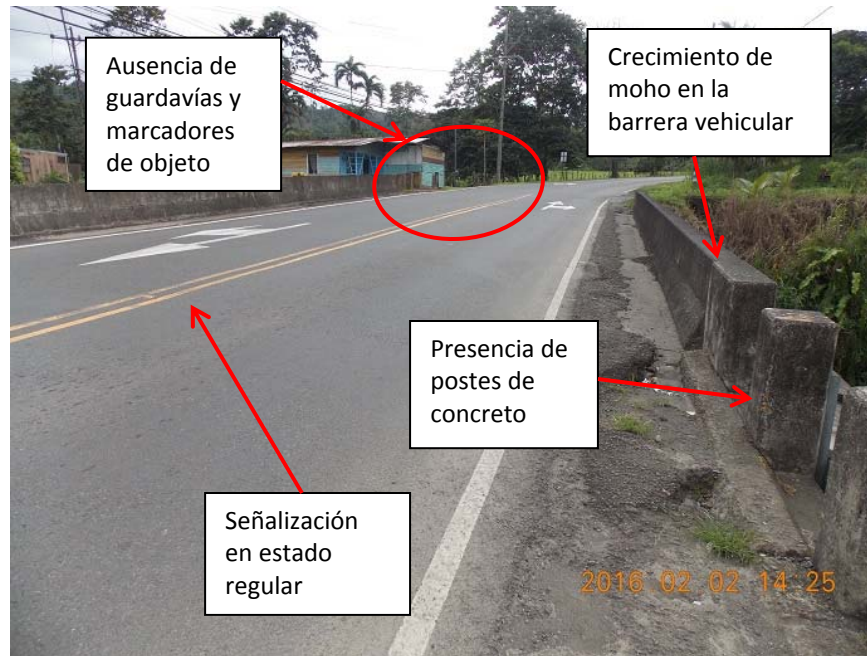
Figura 1. Crecimiento de moho en la barrera vehicular, ausencia de aceras o bordillos, ausencia de guardavías y marcadores de objeto y señalización en estado regular.
