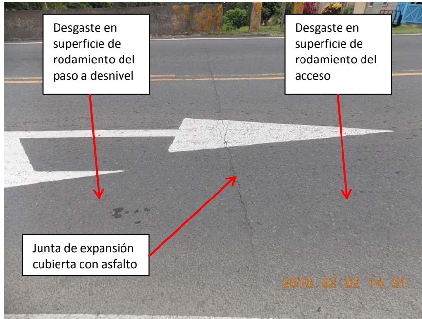
Figura 3. Desgaste en la superficie de rodamiento del acceso 2 y en la superficie de rodamiento del puente.
