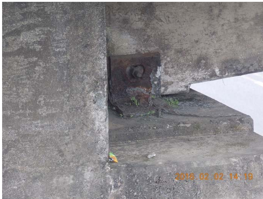
Figura 8. Oxidación generalizada en los elementos metálicos de apoyo exterior sobre el bastión 1.
