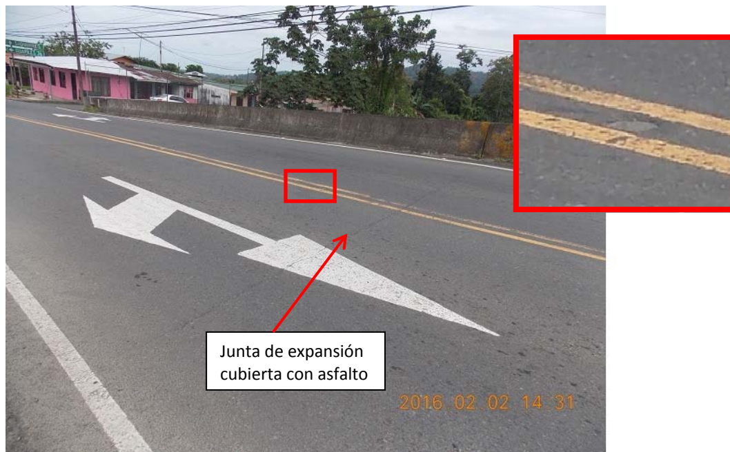
Figura 2. Demarcación horizontal en estado regular, junta de expansión cubierta con asfalto, faltante de captaluces, faltante de acera o bordillo.
