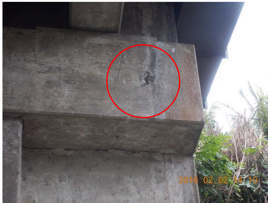
Figura 10. Desprendimiento de concreto con exposición del refuerzo en viga cabezal del bastión 2.
