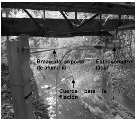
Figura 15.- Detalle de fijación del extensómetro láser para la medición del desplazamiento vertical de un punto en el puente.
