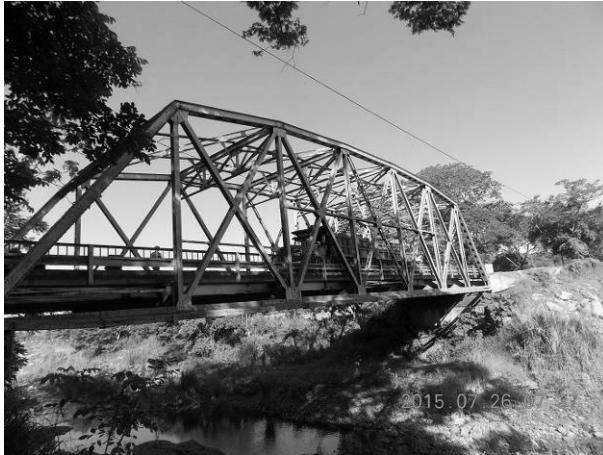
Figura 2.- Vista lateral del costado Sur
