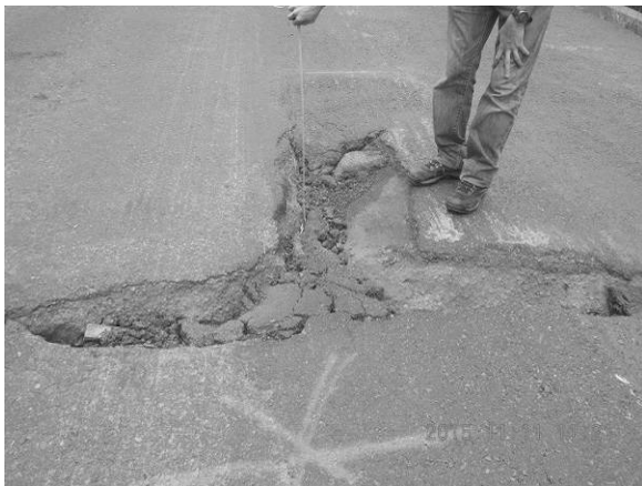
Figura 3.- Daño en el tablero contigua a la junta de expansión del acceso 1 (Oeste, lado de Barranca) en noviembre del 2015.
