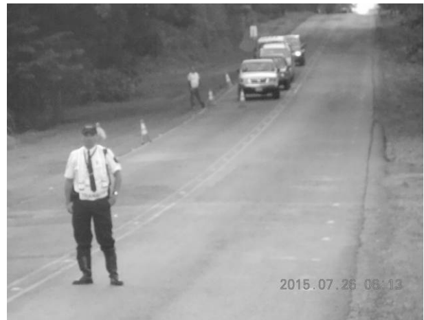
Figura 5.- Manejo del tránsito y presencia policial durante la prueba de carga estática
