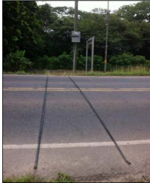
Figura 2. Instalación de contadores de vehículos por la Dirección de Planificación Sectorial.
