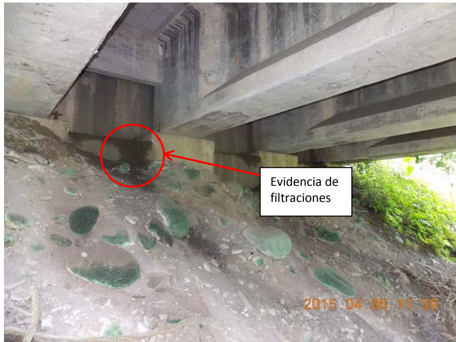
Figura 17. Filtraciones sobre el Bastión 1, el talud frente al bastión no cuenta con protección.
