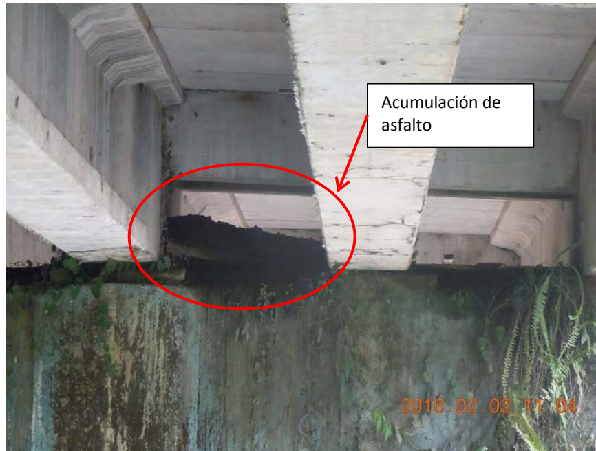
Figura 10. Evidencia de filtraciones, crecimiento de vegetación y acumulación de asfalto sobre la pila 2.
