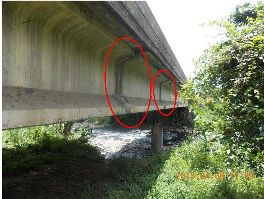
Figura 7. Evidencia de descarga directa de agua sobre las vigas. Obsérvese que los drenajes no cuentan con tubos de extensión.
