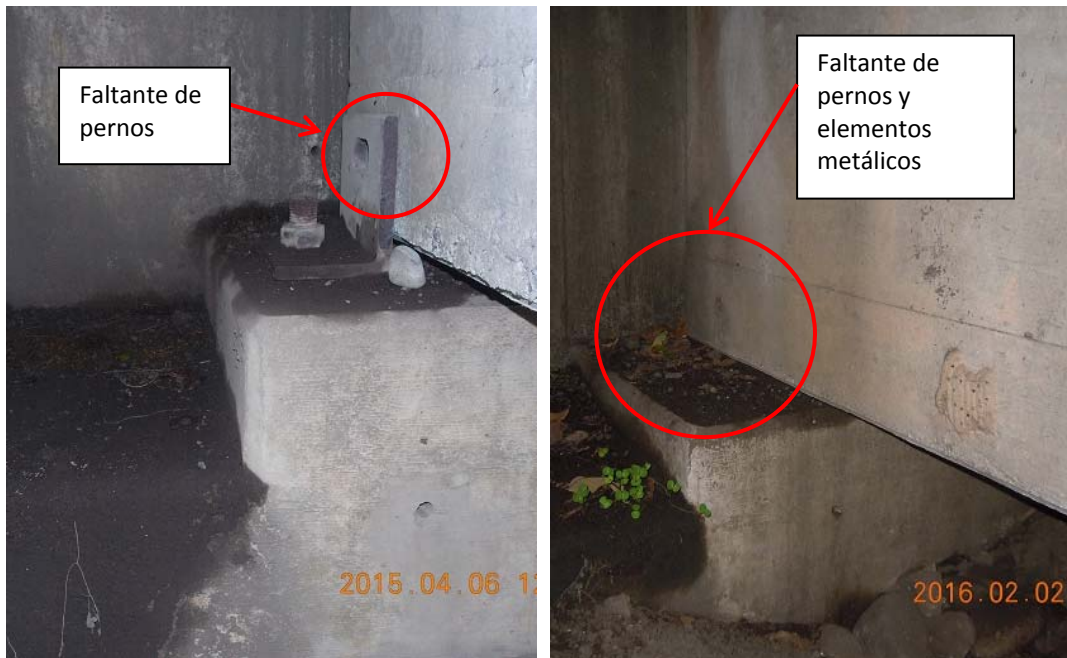
Figura 15. Apoyos en contacto con sedimentos, oxidación de elementos metálicos y de pernos.
