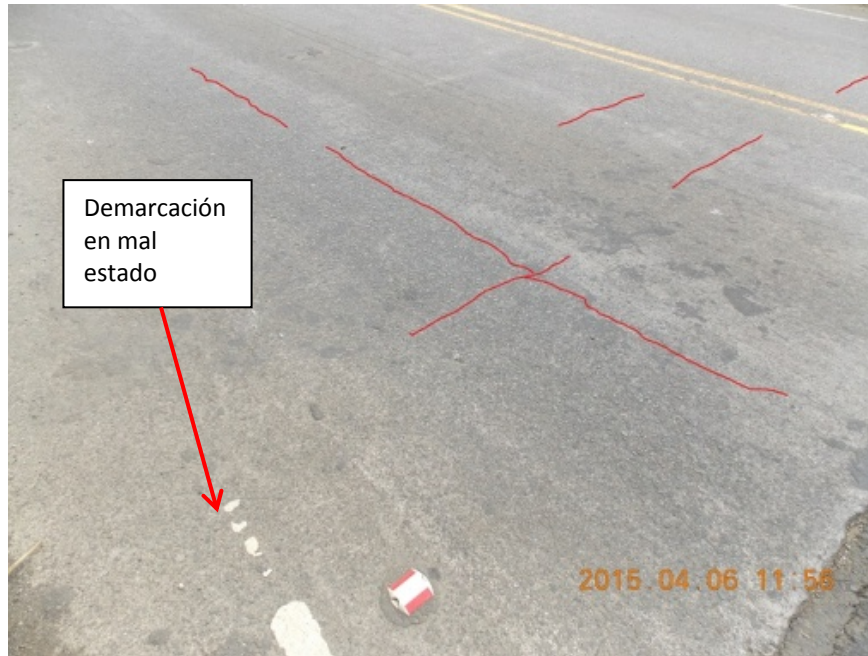
Figura 12. Agrietamiento visible en la cara superior del tablero.
