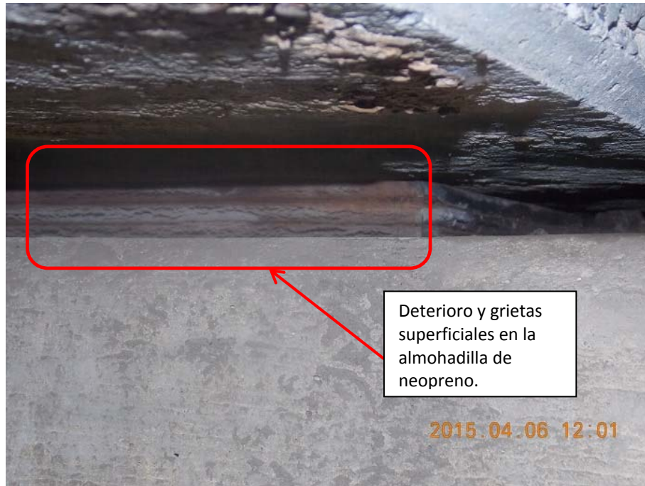
Figura 16. Almohadilla de neopreno con deterioro y agrietamiento superficial.
