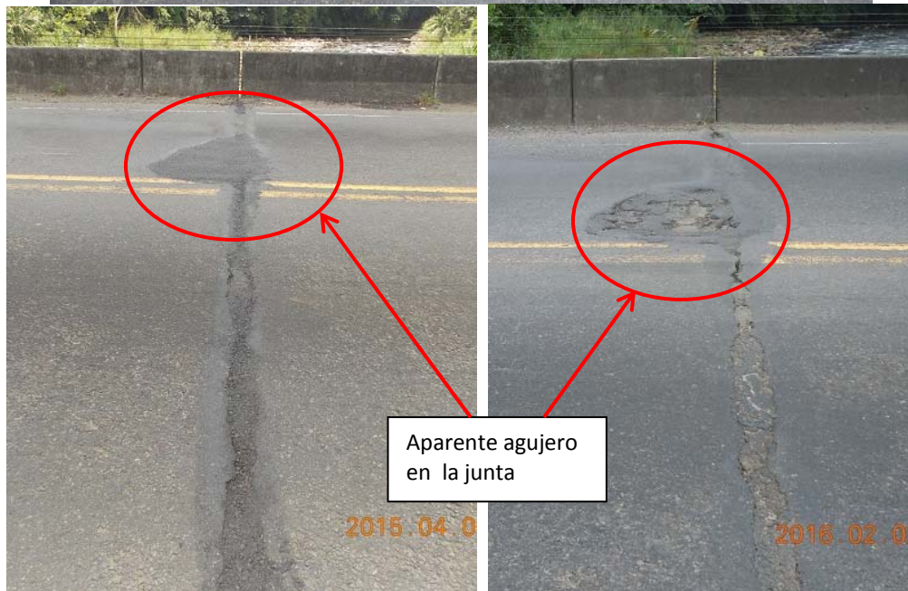
Figura 9. Junta de expansión obstruida con asfalto sobre la pila 2 (setiembre del 2014 arriba, abril del 2015 abajo a la izquierda y febrero del 2016 abajo a la derecha). Nótese un agujero que fue rellenado con.
