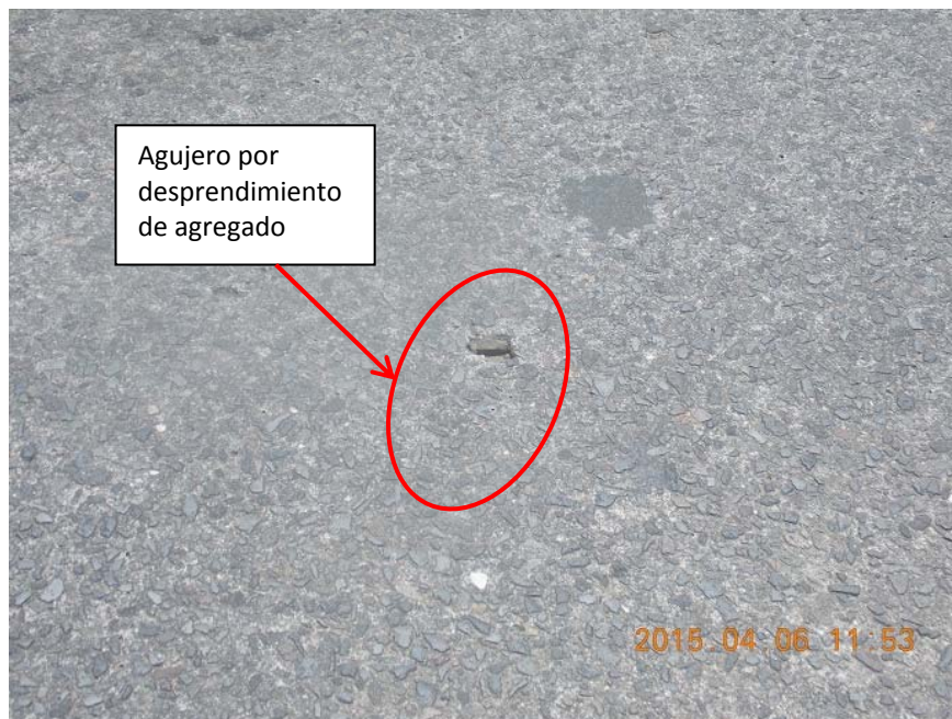
Figura 13. Desgaste de la superficie de rodamiento y desprendimientos de agregado.
