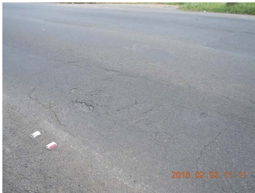
Figura 11. Asentamiento y agrietamiento en la superficie de rodamiento del acceso 1
