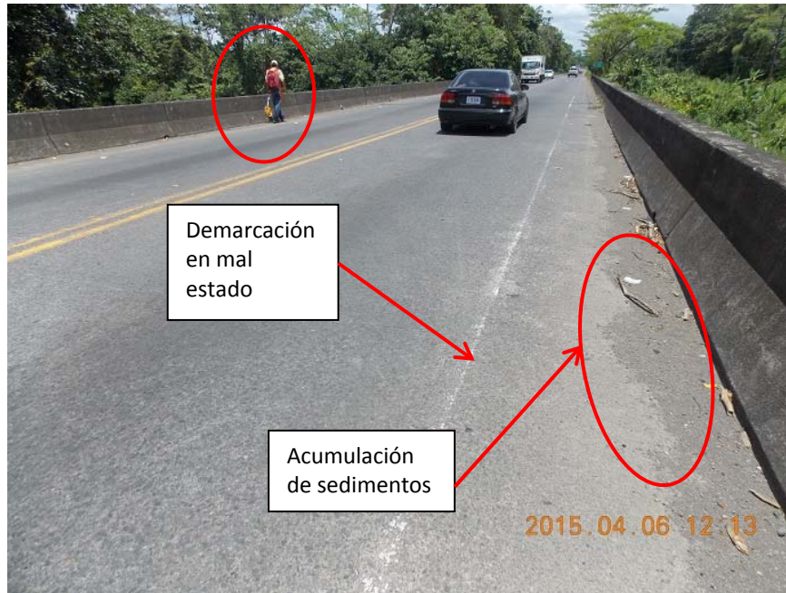
Figura 3. Ausencia de aceras y bordillos de seguridad, nótese al inspector caminando sobre la superficie de rodamiento.
