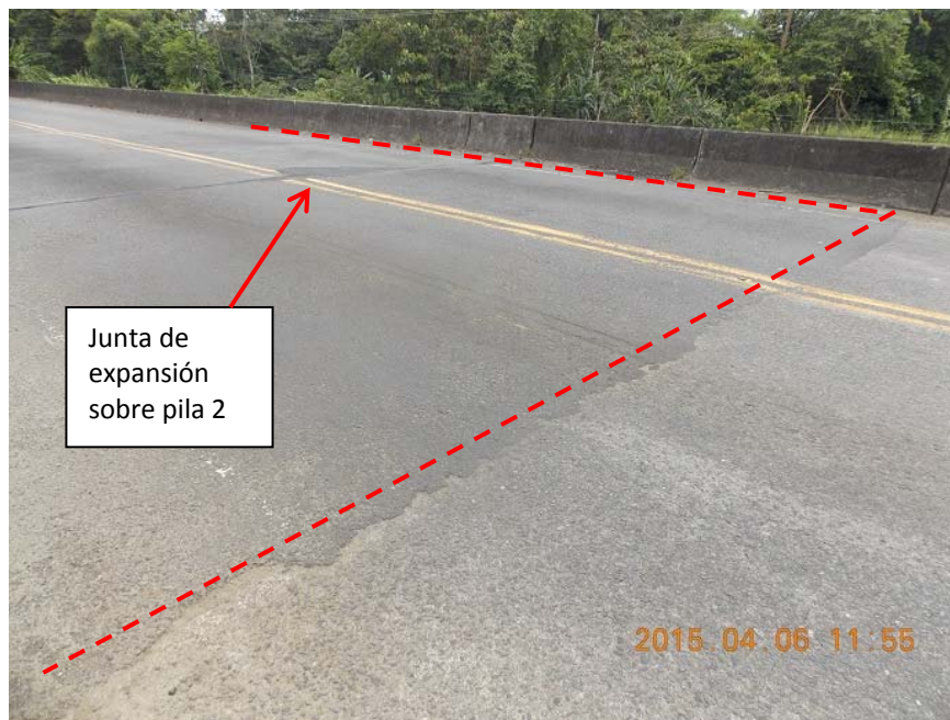
Figura 6. Sobrecapa de asfalto ubicada sobre la pila 2.
