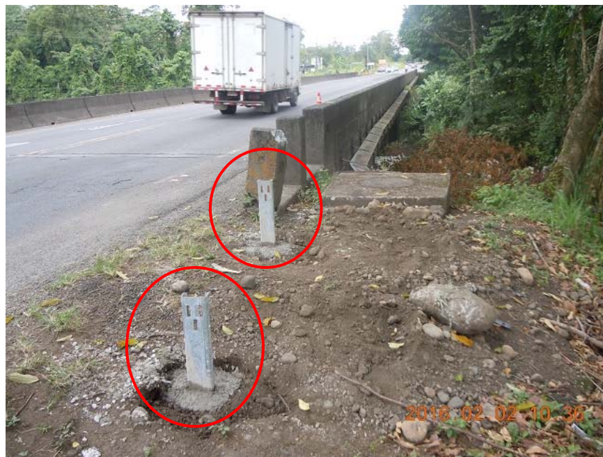
Figura 2. Trabajos de colocación de guardavías.
