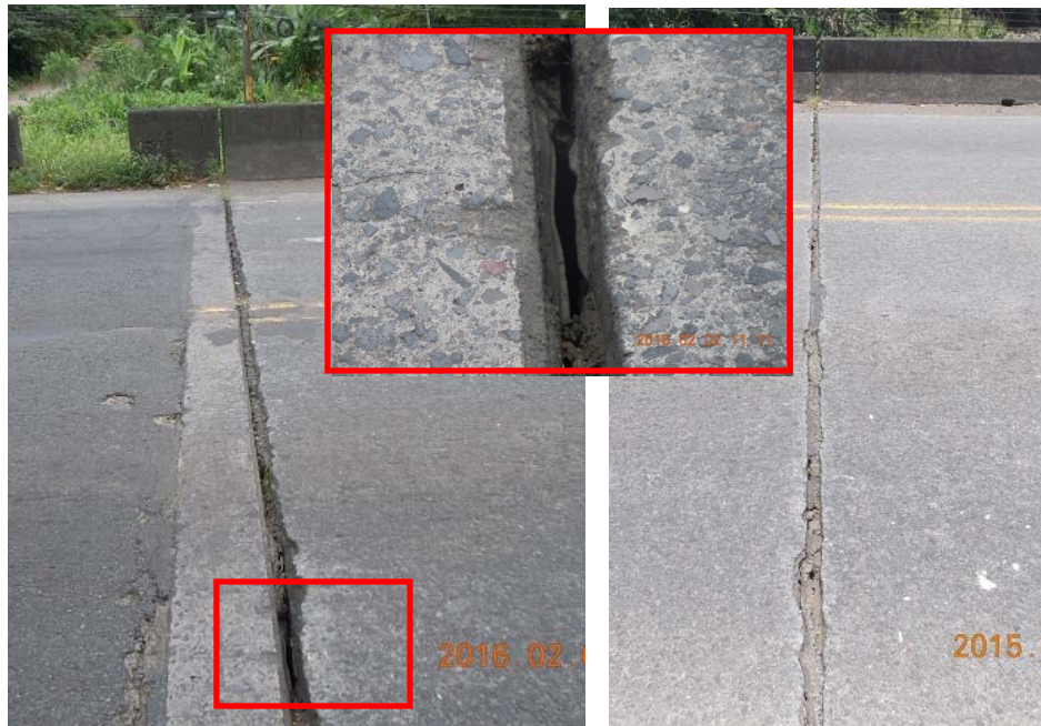
Figura 8. Juntas de expansión sobre bastión 1 y pila 1, nótese el deterioro del sello.
