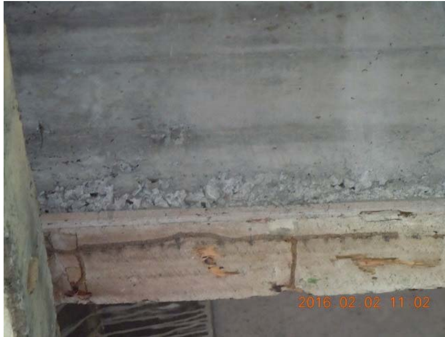
Figura 14. Nidos de piedra en viga diafragma.
