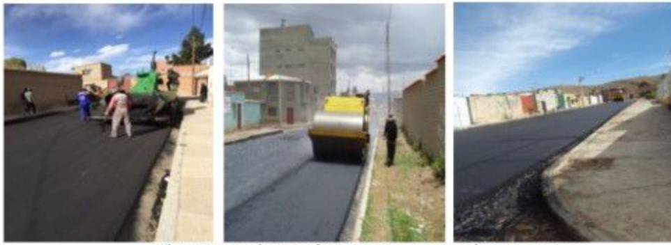
Figura 6 Pavimentado J. V. Nuevos Horizontes, Oruro
