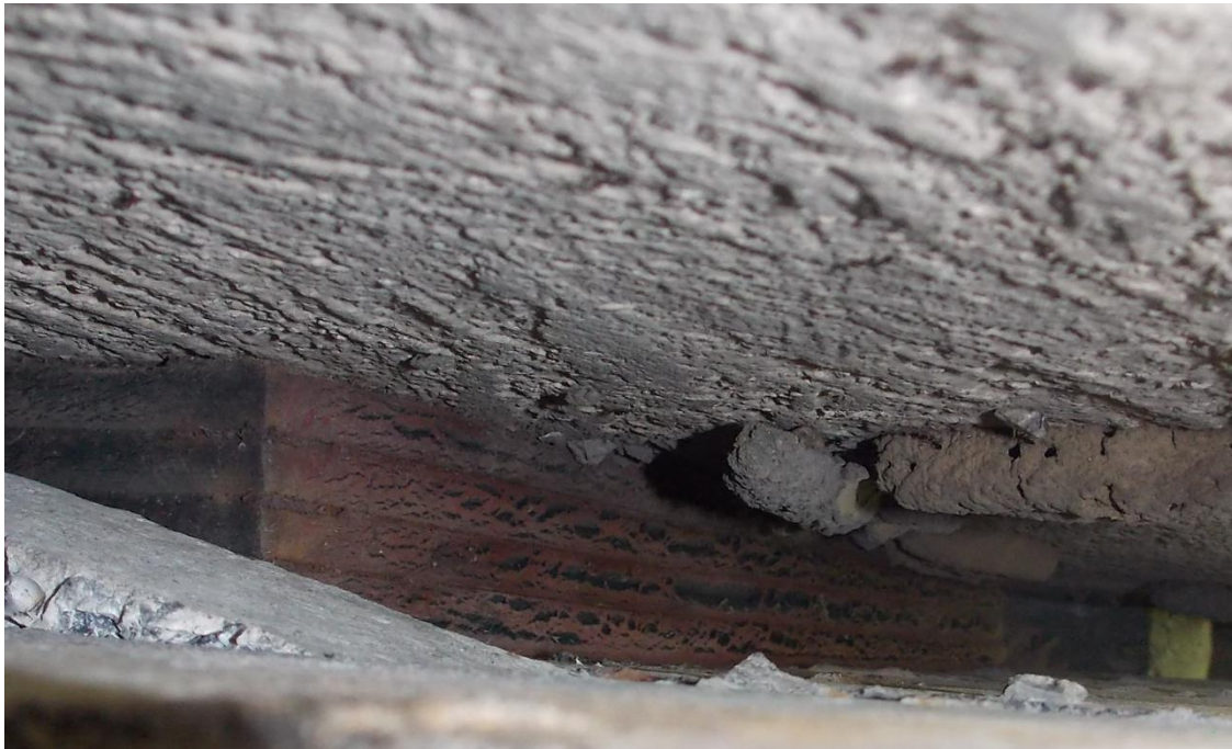
Figura 14. Rotura superficial y abultamiento en almohadillas elastoméricas.
