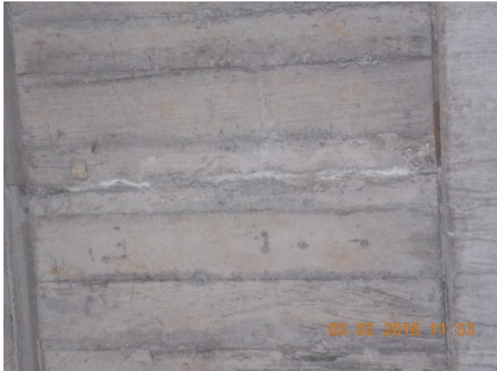
(a) Cara inferior de la losa en la superestructura 1
