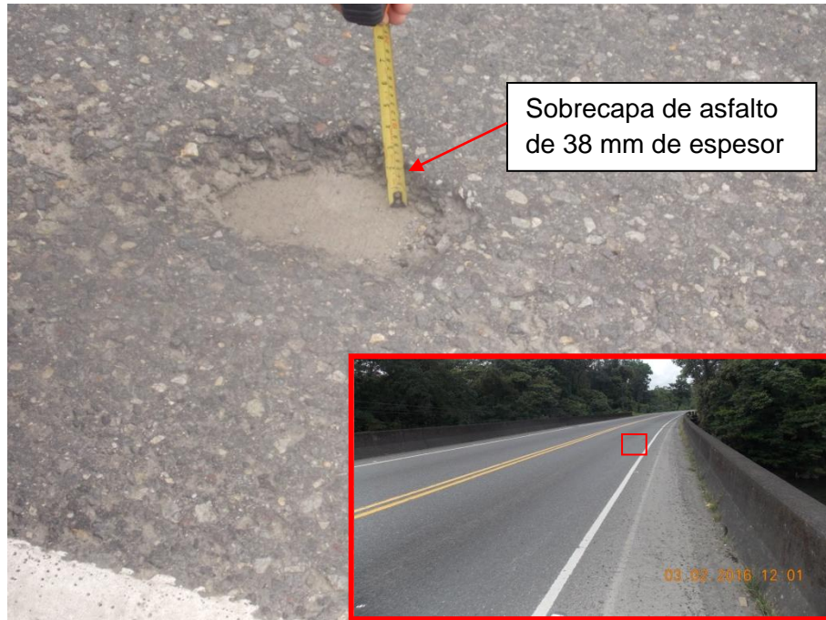
Figura 5. Sobrecapa de asfalto colocada como superficie de rodamiento en el puente.
