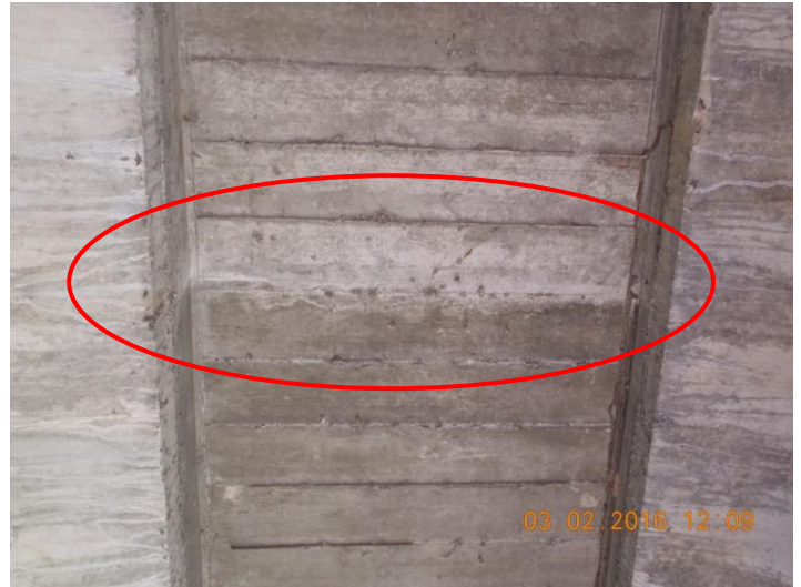
(b) Cara inferior de la losa en la superestructura 2
