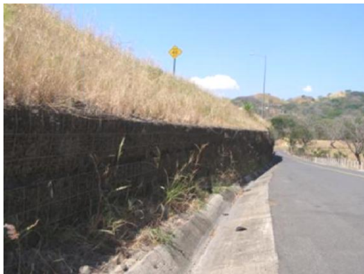
Figura 35 Muro mecánicamente estabilizado en la intersección hacia Balsa
