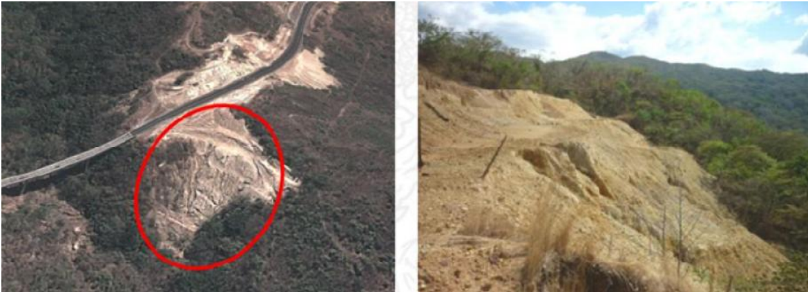
Figura 56 Estacionamiento 48+100. Izquierda: Vista aérea del relleno. Derecha: Se aprecian las cárcavas producto del lavado del suelo depositado en el lugar.
