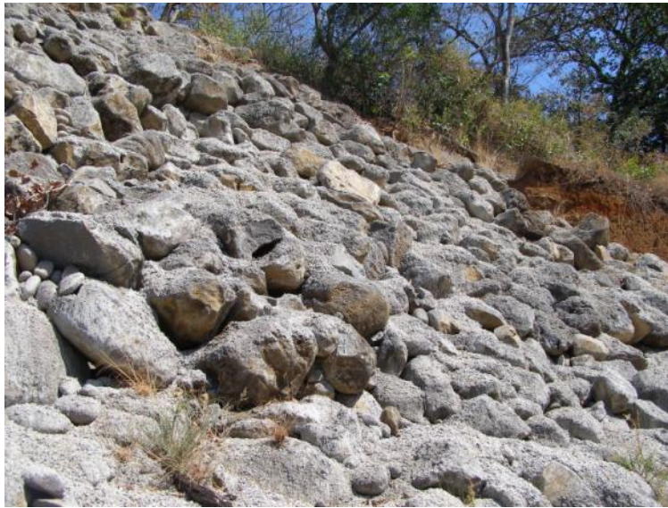
Figura 32 Enrocado kilómetro 22+930, lado derecho
