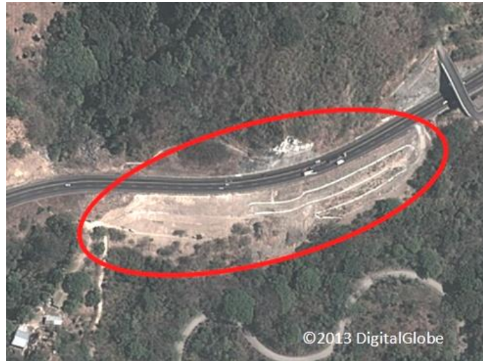
Figura 47 Vista aérea del talud en el kilómetro 44+500.
