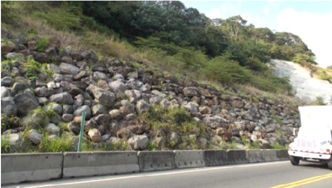
Figura 50 Vista parcial del enrocado construido en el 46+000.
