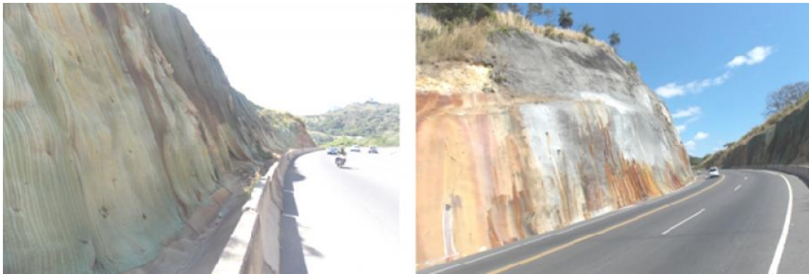
Figura 41 Taludes 38+700. Izquierda: Talud de corte LI. Derecha: Talud lado derecho.
