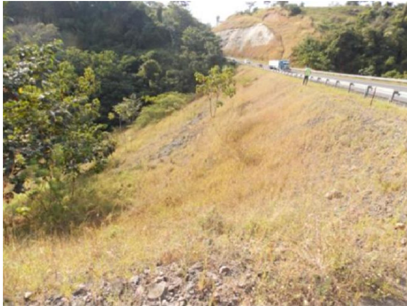
Figura 44 Relleno quebrada Lapas. LI en el sentido SJ – Caldera.
