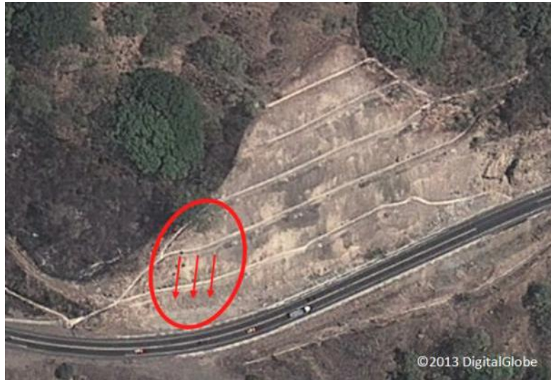
Figura 37 Vista aérea del talud en PK 36+400. Se indica la zona y la dirección del deslizamiento observado.
