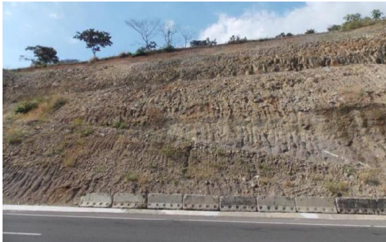
Figura 57 Vista frontal del talud de corte localizado en el estacionamiento 48+400.
