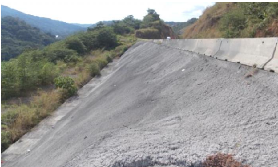
Figura 51 Vista del talud de corte al lado izquierdo del PK 46+300.
