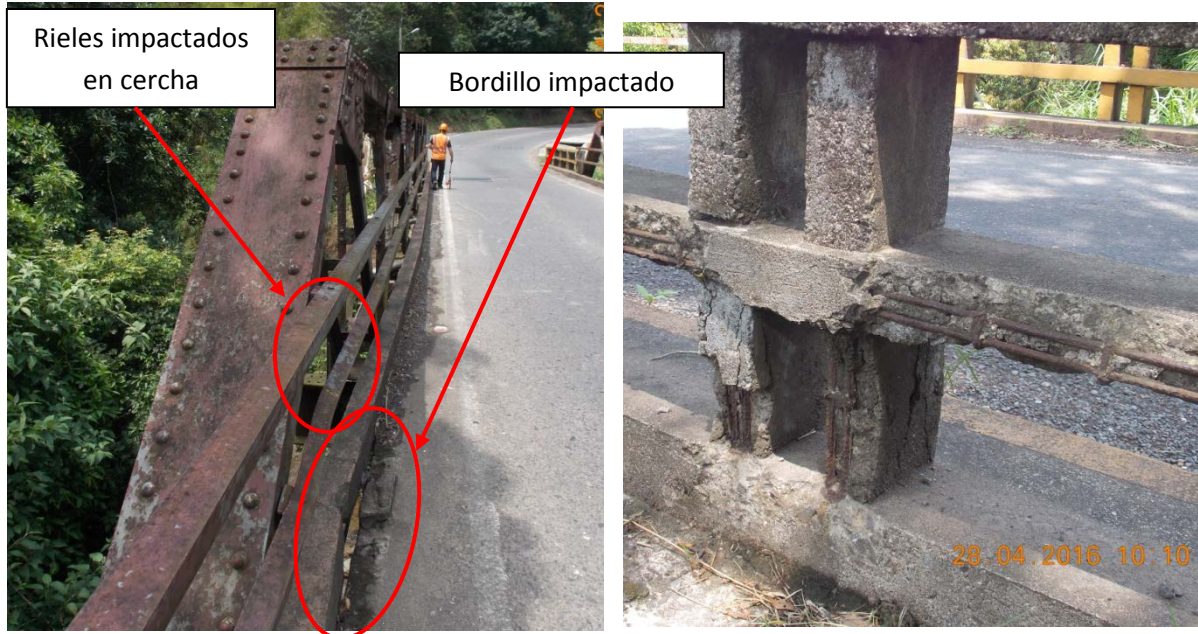
Figura 1. Daños en la barrera vehicular de concreto con acero expuesto y los rieles en la cercha
