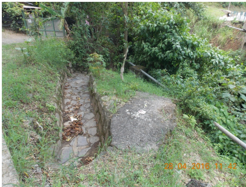
Figura 8. Manejo de agua acceso 1, aguas arriba
