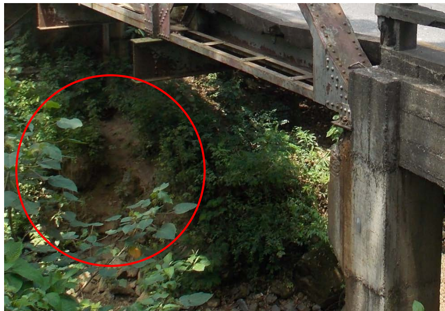
Figura 20. Erosión en el margen izquierdo de la quebrada
