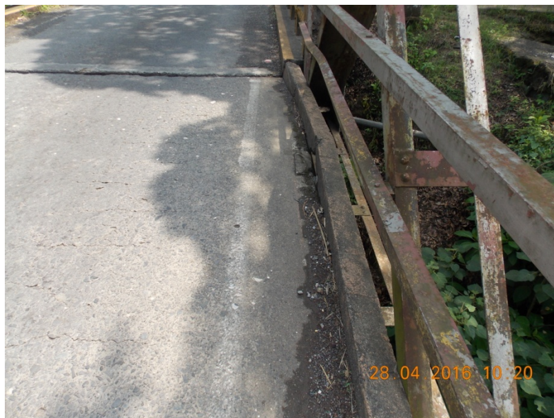
Figura 6. Bordillo desplazado y agujeros de drenaje obstruidos con escombros
