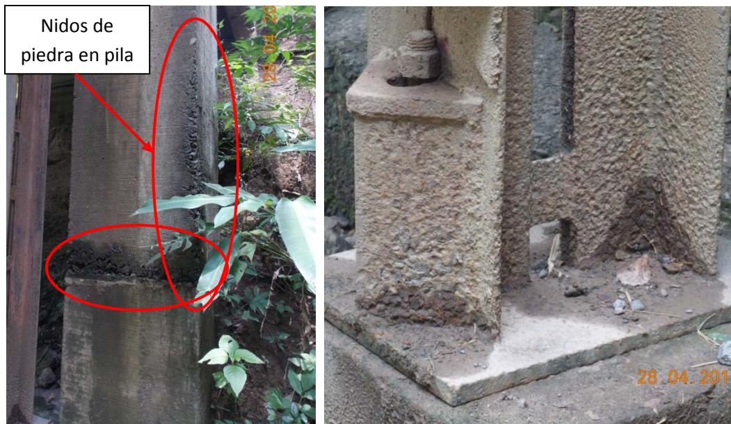
Figura 18. Nidos de piedra en pila de concreto y corrosión en el pie de la pila de acero
