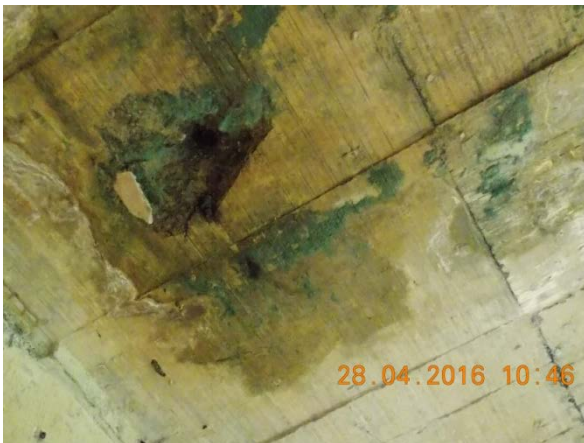
Figura 10. Desprendimientos y agujeros en los tableros de la superestructura 3 y 1
