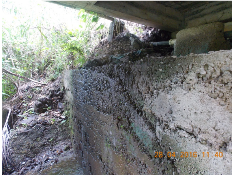
Figura 19. Muro de protección de bastión presenta juntas constructivas evidentes y nidos de piedra
