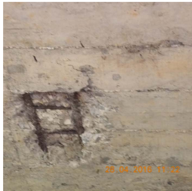
Figura 10. Desprendimientos y agujeros en los tableros de la superestructura 3 y 1
