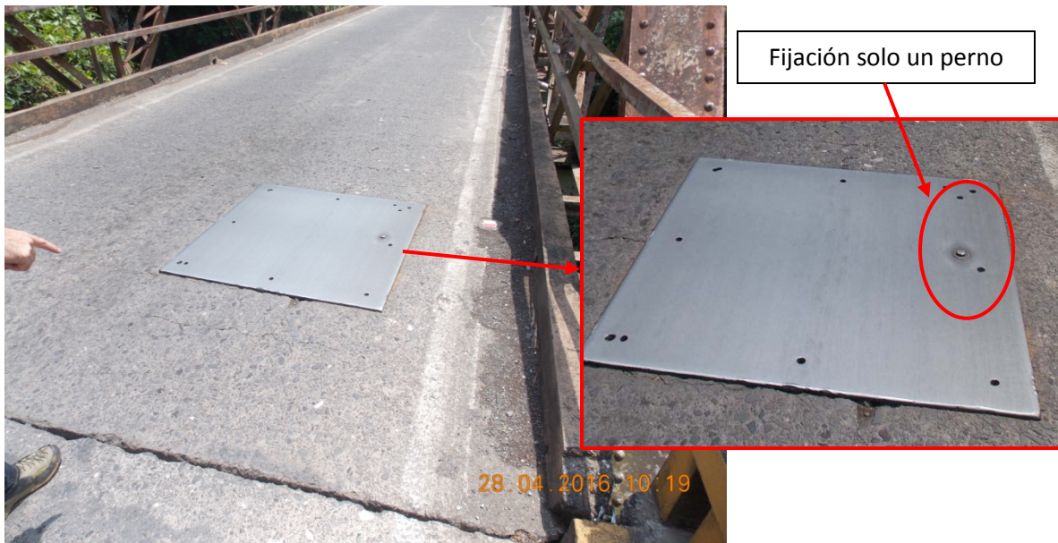
Figura 4. Placa en tablero (solo un perno de fijación) y escombros
