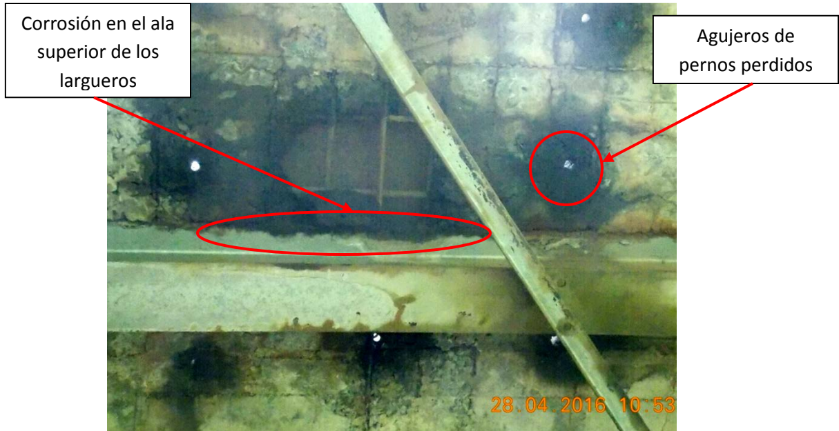
Figura 13. Largueros con alas corroídas y agujero en tablero. Desprendimientos y acero expuesto (inclusive cortado) en losa del tablero
