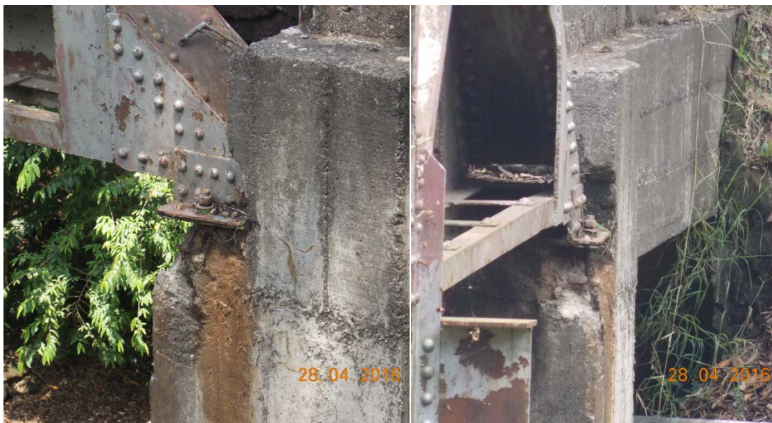
Figura 16. Movimiento vertical, desprendimiento de concreto y pérdida de soporte del apoyo en superestructura 2 en la margen derecha del río (costado este)
