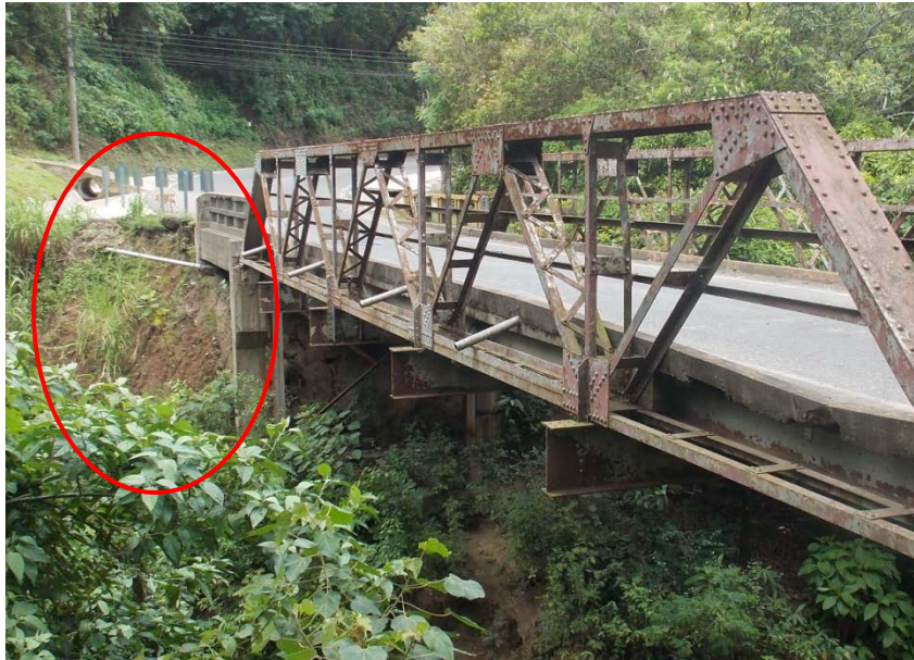
Figura 7. Escarpe en relleno de aproximación en acceso 2
