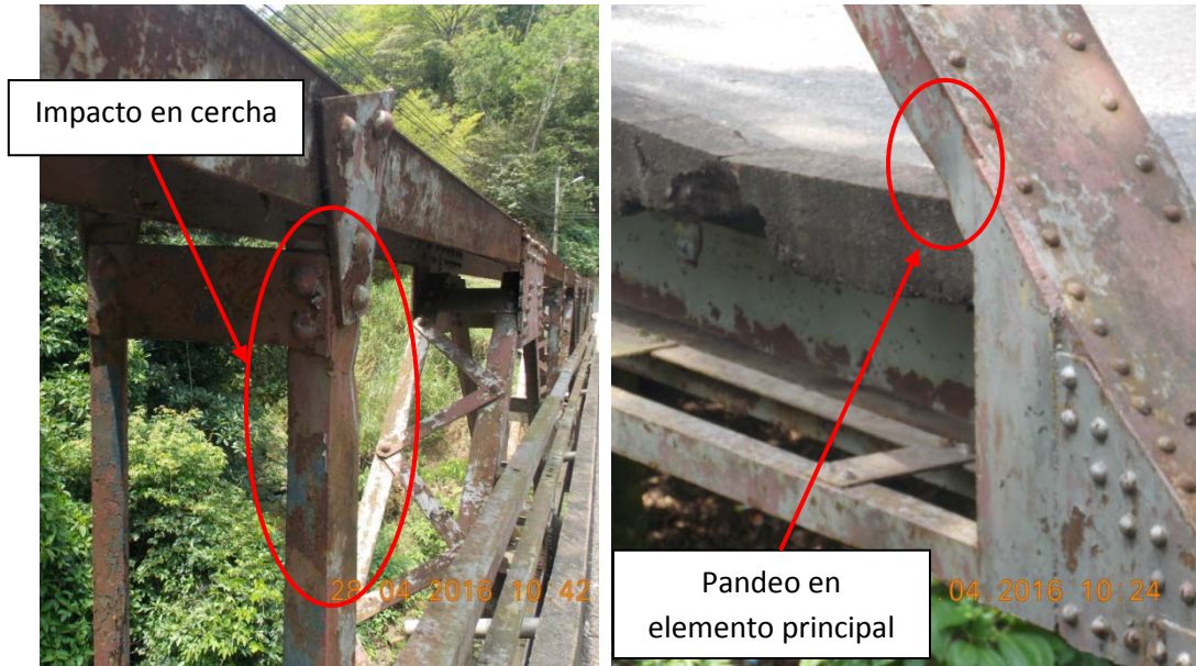
Figura 11. Daños en la cercha principal
