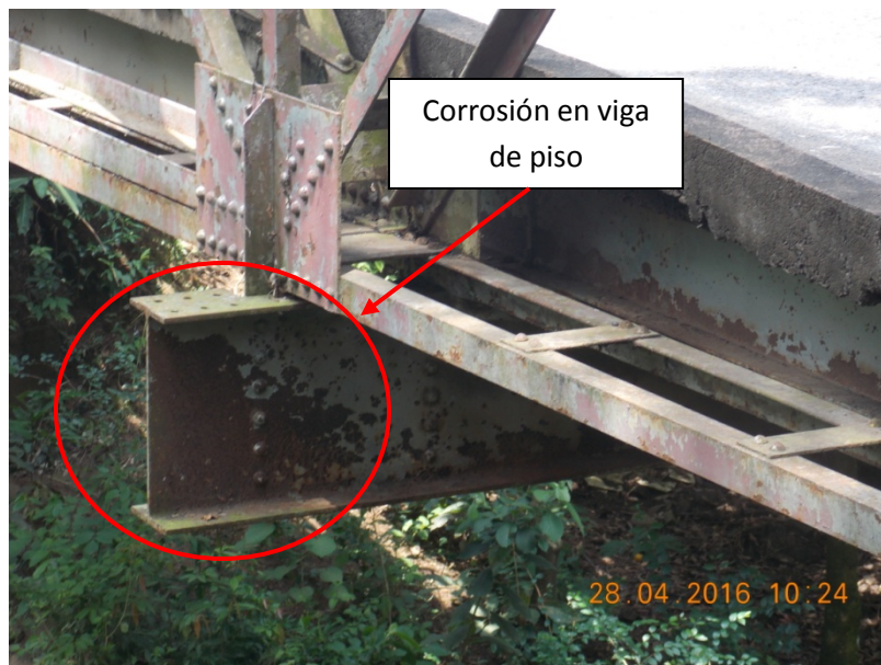
Figura 12. Corrosión en vigas de piso
