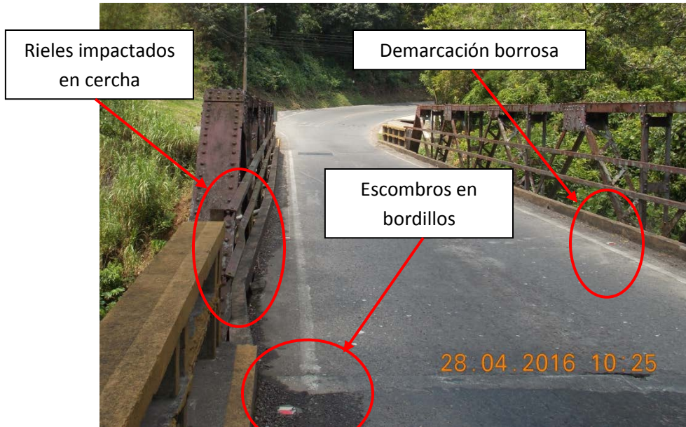
Figura 3. Ausencia de acera, demarcación borrosa, escombros, ausencia de suficientes marcadores de objeto
