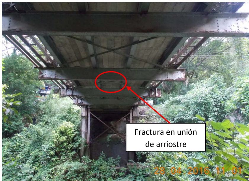
Figura 14. Arriostre suelto en tramo central superestructura 2
