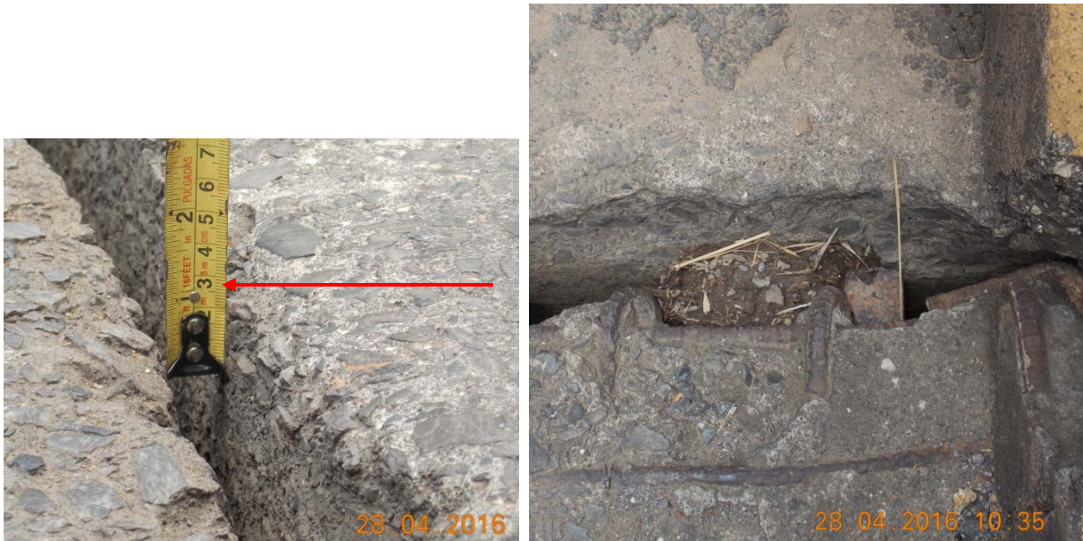
Figura 5. Desnivel entre la superestructura 1 y la 2. Agujero y acero expuesto en junta entre suerestructura 2 y 3.
