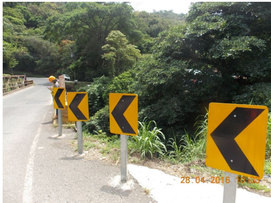
Figura 2. Ausencia de guardavías y marcadores de objeto en la aproximación del puente
