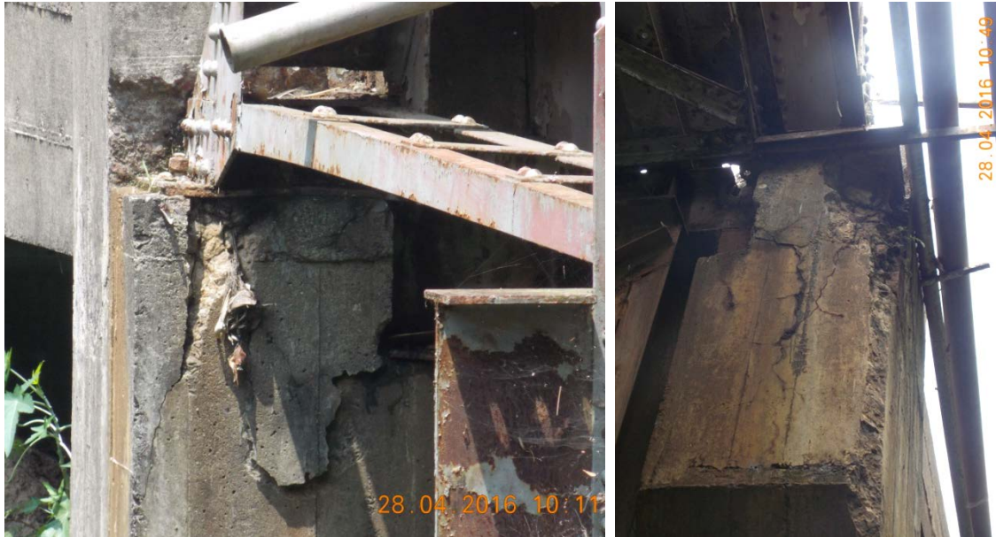
Figura 15. Acero expuesto, desprendimiento y agrietamiento en pedestal de apoyo en la superestructura 2 en la margen izquierda del río (costado oeste y este)
