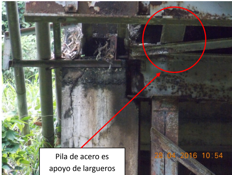
Figura 17. Soporte adicional en largueros del puente
