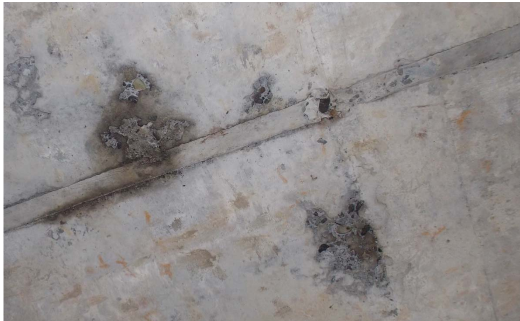
Figura 9. Nidos de piedra de menor tamaño en la cara inferior de la losa.
