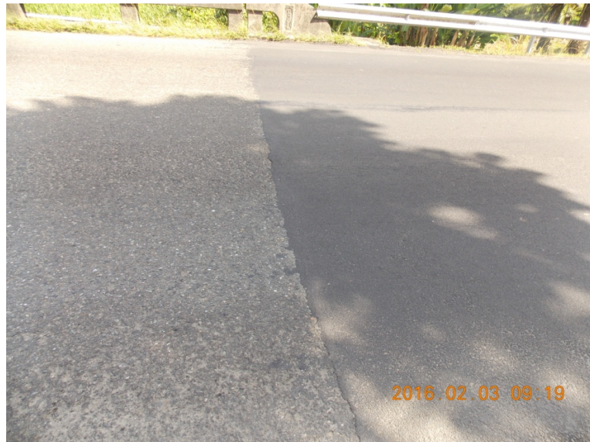
Figura 7. Obstrucción de la junta de expansión del acceso 1 por una sobrecapa asfáltica.
