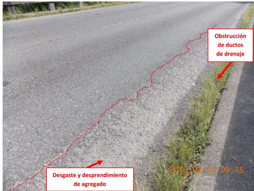
Figura 4. Desgaste de la carpeta asfáltica con desprendimiento de agregado, grieta longitudinal paralela al bordillo y obstrucción de los ductos de drenaje.
