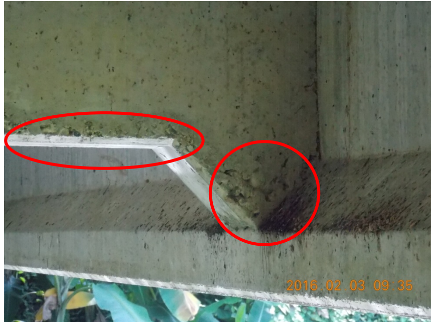
Figura 10. Nidos de piedra en los bordes de las vigas diafragma.
