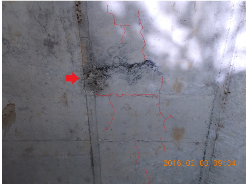
Figura 8. Agrietamiento y nido de piedra de dimensión mayor a 10cm en la cara inferior de la losa.
