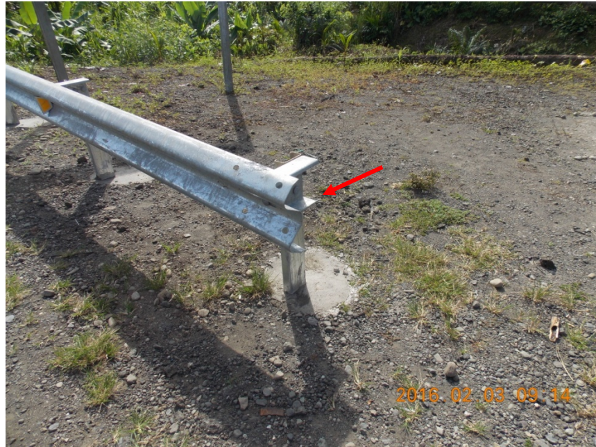
Figura 2. Terminación inadecuada de los guardavías y postes enterrados en bases de concreto.
