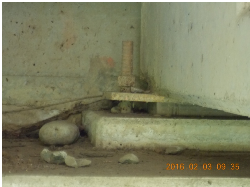
Figura 11. Oxidación superficial de los elementos metálicos de los apoyos.
