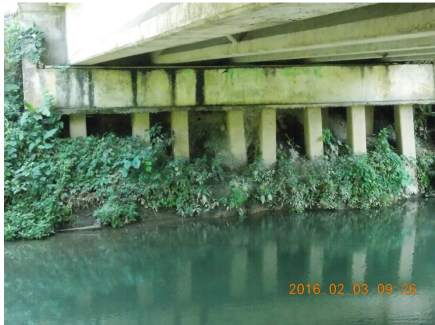
Figura 13. Pilotes del bastión 1 expuestos.
