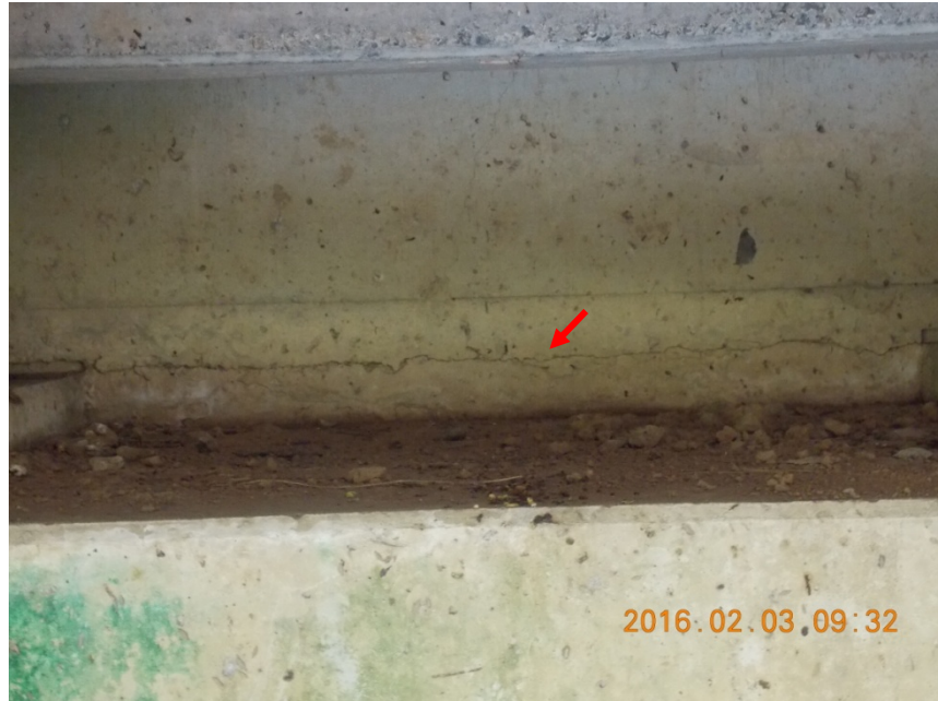
Figura 12. Grieta horizontal en la pared del cabezal del bastión 2.
