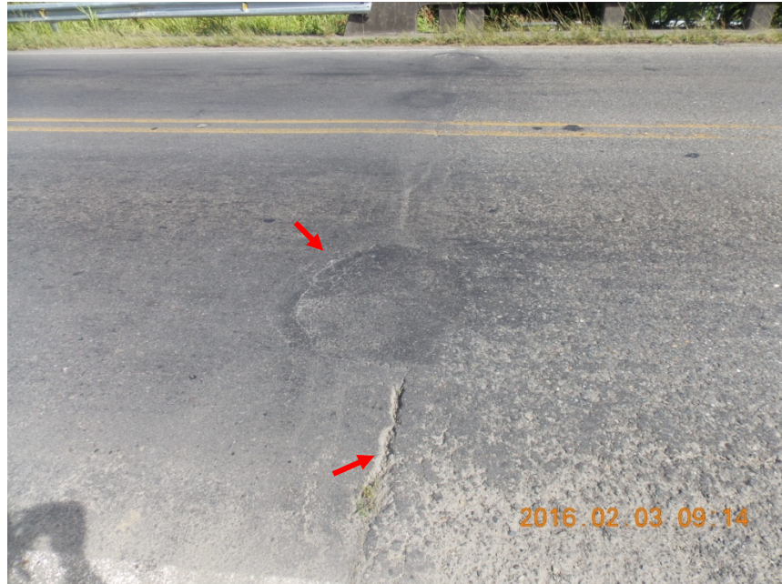
Figura 6. Obstrucción de la junta de expansión del acceso 2 por una sobrecapa asfáltica, agrietamiento y baches sobre la junta.
