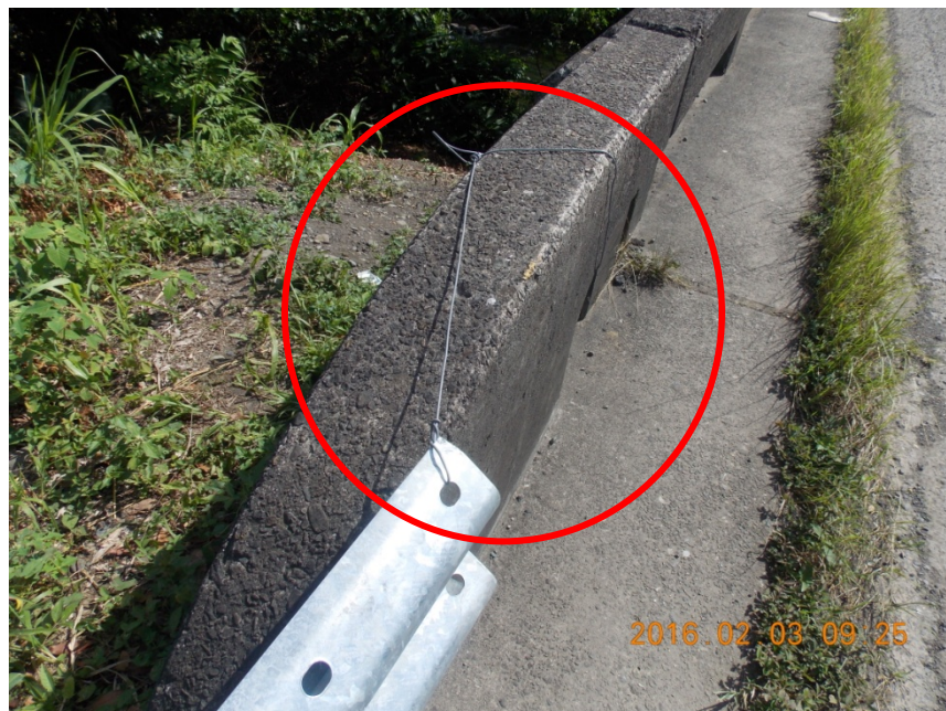
Figura 1. Transición inadecuada de los guardavías hacia la barrera vehicular del puente.
