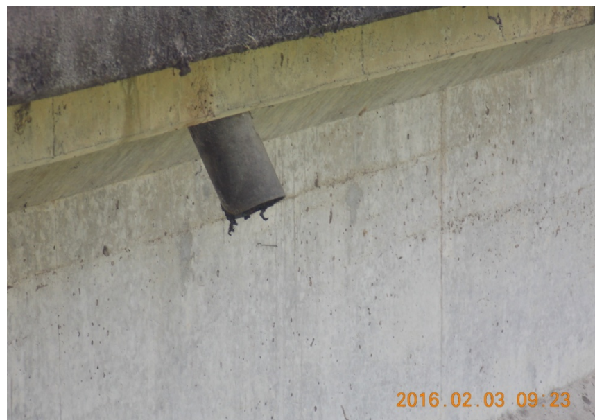
Figura 5. Extensión insuficiente de los ductos de salida del sistema de drenaje.
