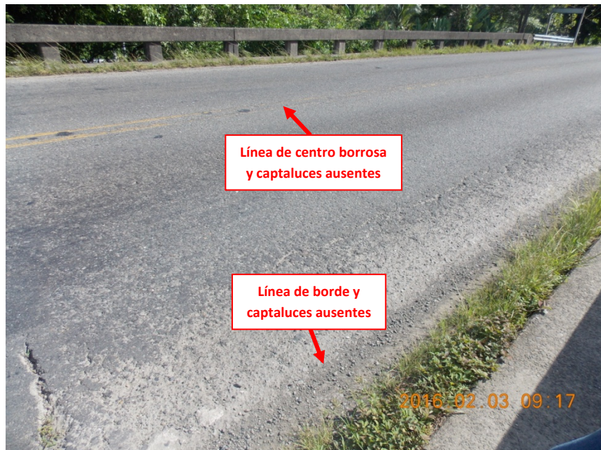
Figura 3. Demarcación horizontal en mal estado y captaluces ausentes.
