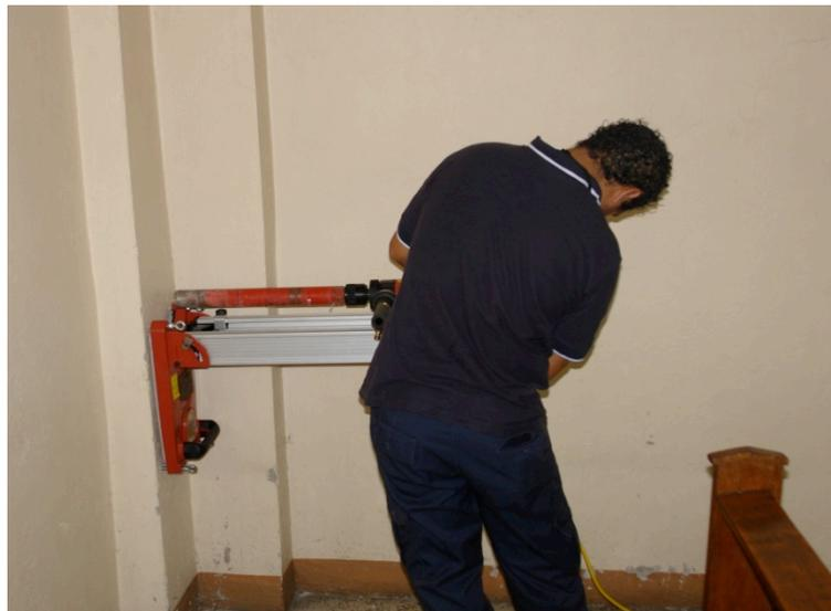
Preparación de una superficie para extracción
