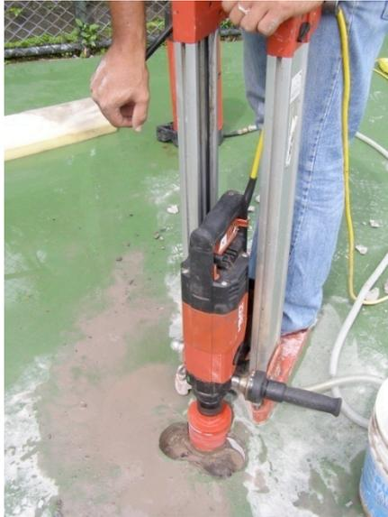
Extracción de un núcleo de concreto
