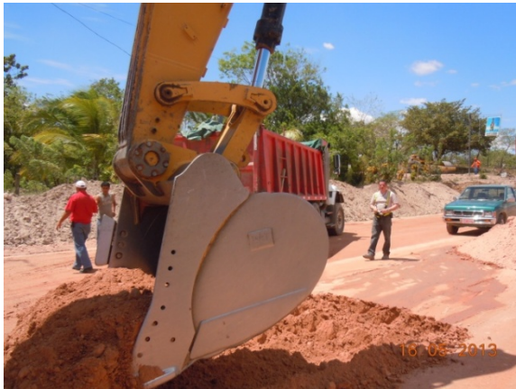
Fotografías 1 y 2. Muestreo de material de préstamo del proyecto Cañas-Liberia el día 16/05/2013 estacionamiento 192+320.
