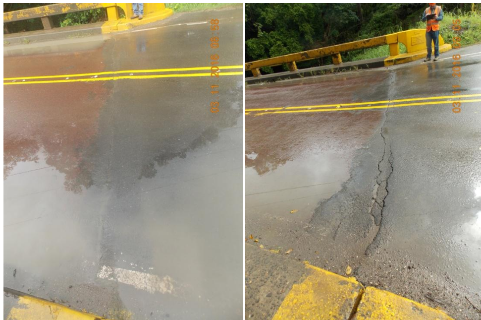
Figura 5. Carpeta asfáltica sobre las juntas de expansión.
