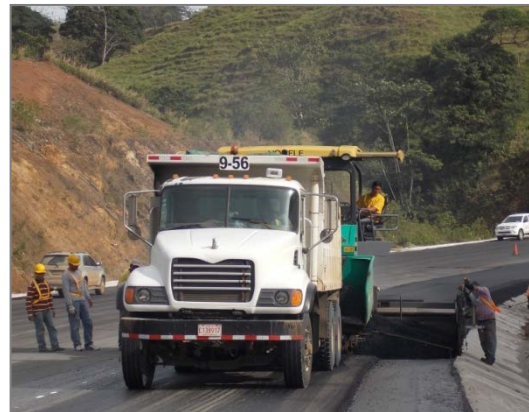
Figura 7. Vagoneta No. 9-56 (tipo C3) durante el proceso de colocación de mezcla asfáltica, estación 32+980. Fecha: 17 de marzo de 2015.
