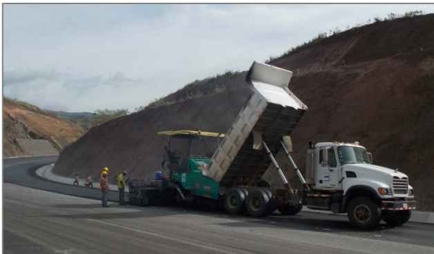
Figura 7. Vagoneta No. 9-56 (tipo C3) durante el proceso de colocación de mezcla asfáltica, estación 32+980. Fecha: 17 de marzo de 2015.
