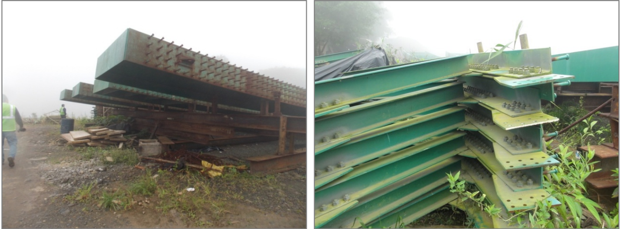
Figura 14. Elementos de la superestructura del puente sobre el Río La Vieja apilados a la intemperie. (Ramirez-Villalba & Castillo-Barahona, 2015)
