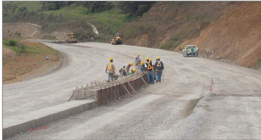
Figura 5. Frente de obra. Estación 12+480. Fecha: 13 de mayo de 2015. Fuente: LanammeUCR.
