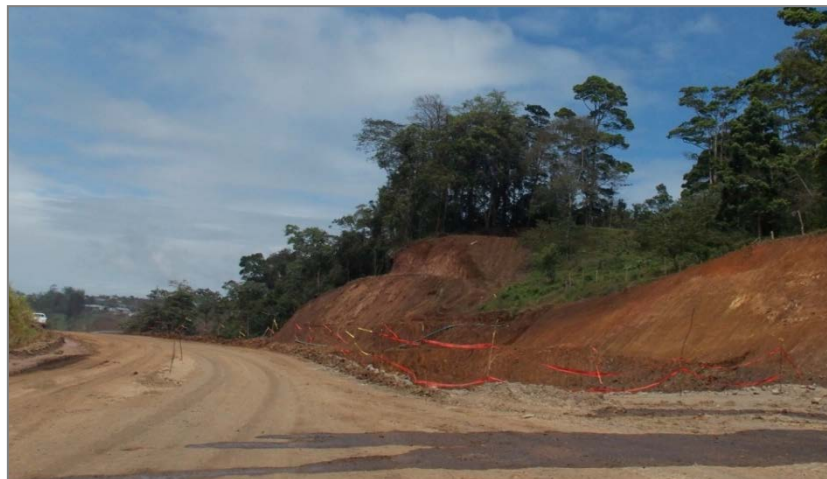
Figura 4. Excavación para alcantarilla. Estación 37+400. Fecha: 24 de febrero de 2015. Fuente: LanammeUCR.
