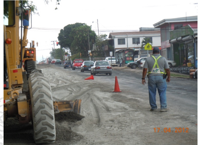
Fotografía 4. Separación del flujo vehicular y la zona de trabajo Fecha:17/04/2012
