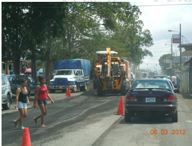
Fotografía 10. Tránsito de peatones en el área de trabajo. Fecha 07/02/2012
