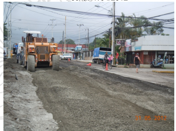
Fotografía 6. Separación del flujo vehicular y la zona de trabajo Fecha:31/05/2012
