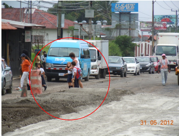
Fotografía 12. Tránsito de peatones en el área de trabajos. Fecha:31/05/2012
