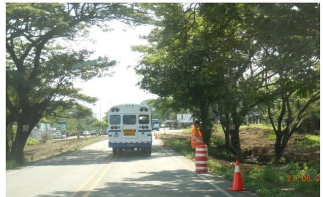
**Fotografía 26 y Fotografía 27.** Demarcación de frentes de trabajo combinadas barreras y barriles.
