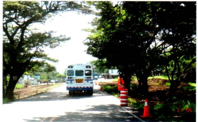
**Fotografía 12 y 13.** Demarcación de frentes de trabajo combinadas barreras y estañones.
