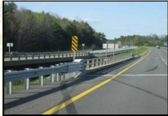
Fotografía 26. Ejemplo de transición adecuada en puentes.
