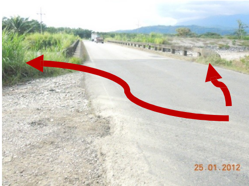
Fotografía 16. Ubicación: Zona 4-3, Zona Sur, Ruta 2, puente sobre el Río Claro. Fecha de la visita: 25/01/2012.
