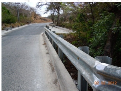
Fotografía 13. Barrera flexible en puente.
