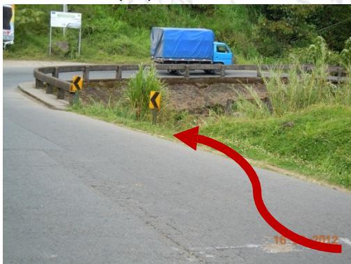
Fotografía 24. Ubicación: Zona 1-8, Turrialba, 200 m antes de Pacayas, sentido San José-Pacayas. Fecha de la visita: 18/02/2012.
