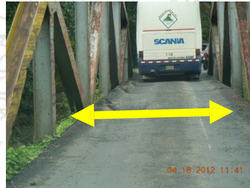
Fotografía 29. Puente sobre el Rio Arenal, angosto tipo "pony" sin pasarela peatonal.
