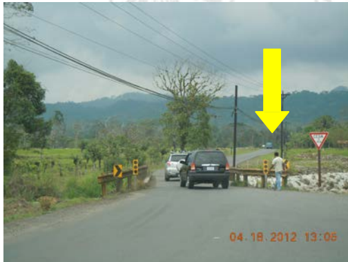
Fotografía 28. Puente sin pasarela peatonal.
