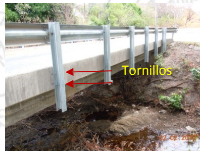
Fotografía 14. Dos tornillos sujetan cada poste a la losa.
