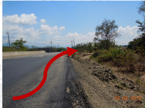
Fotografía 23. Ubicación: Zona 3-2, Quepos, Puente sobre el Río Las Vueltas, Ruta 34 Costanera Sur. Fecha de la visita: 27/02/2012.
