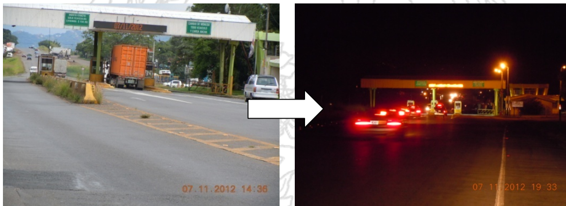
Fotografía 1(a). Barrera divisoria cubierta por maleza que impide la visibilidad de las señales.
