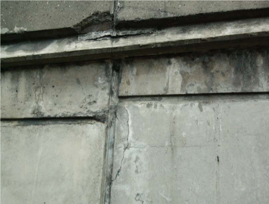
Figura 9: Herrajes de conexión expuestos
