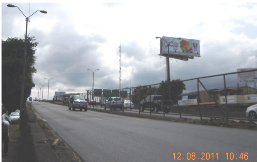
Figura 2: Vista superior del Paso superior Juan Pablo II
