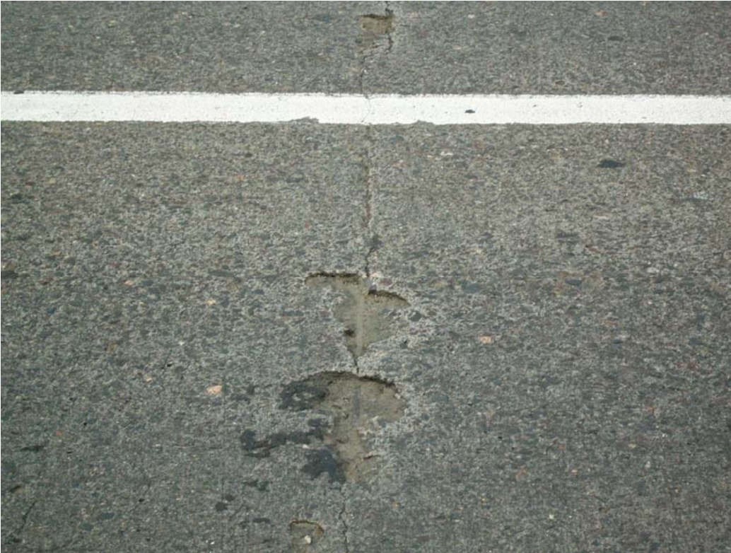
Figura 6: Deterioro en losa de rodamiento
