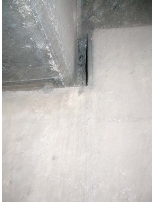
Figura 10: Apoyos elastoméricos en bastiones
