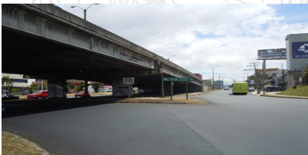
Figura 3. Vista lateral del Paso superior Juan Pablo II
