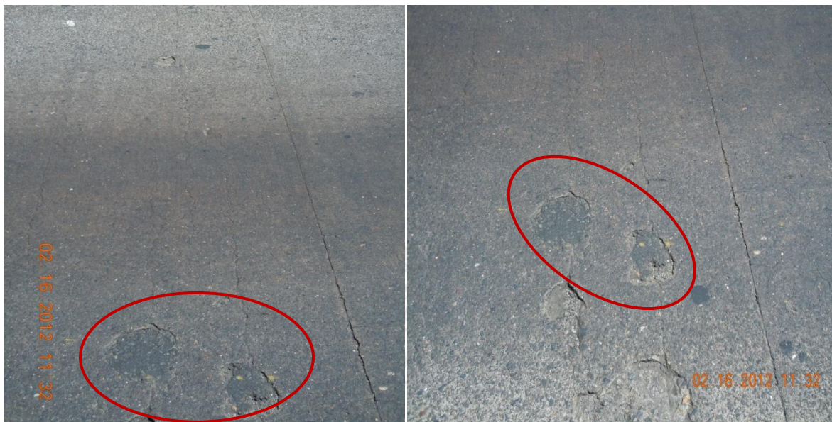
Figura 16. Agujeros en la losa cubiertos con mezcla asfáltica
