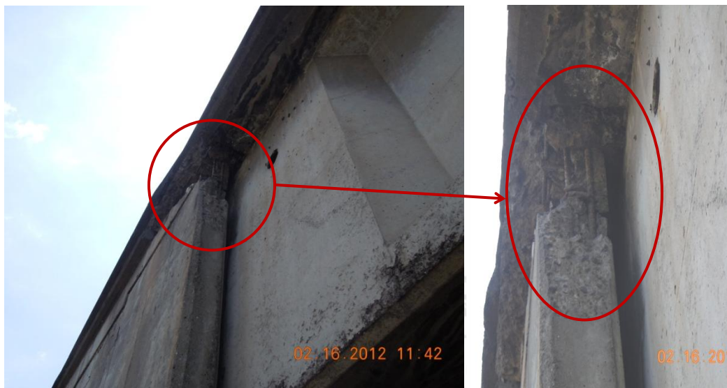
Figura 30. Pérdida del concreto y acero de refuerzo expuesto en el aletón del puente derecho (acceso Sur)
