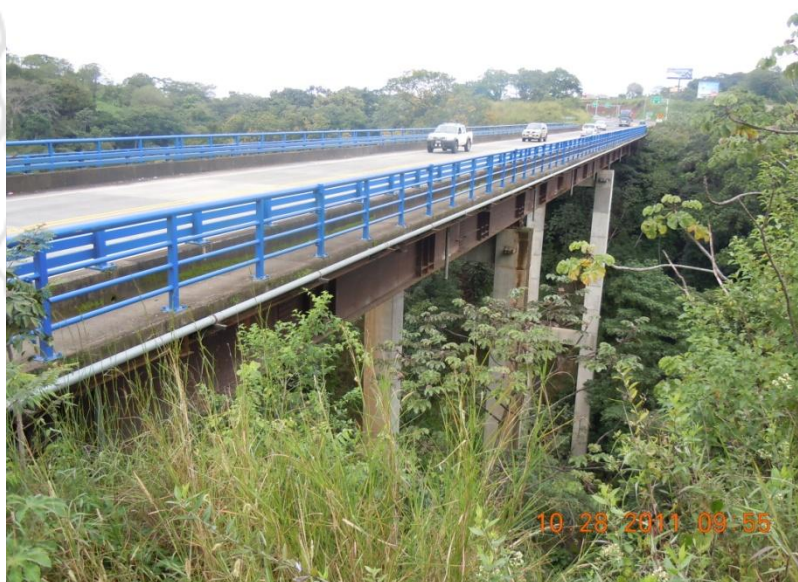
Figura 3. Vista lateral del puente
