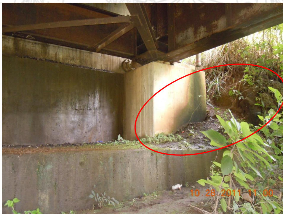
Figura 5. Gradiente de los taludes contiguos a los bastiones que facilita la escorrentía superficial y la acumulación del suelo erosionado en los bastiones y apoyos.
