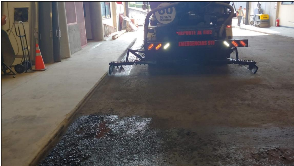
**Figura 30.** Proceso de riego de liga en la construcción de tramos para el HVS.
