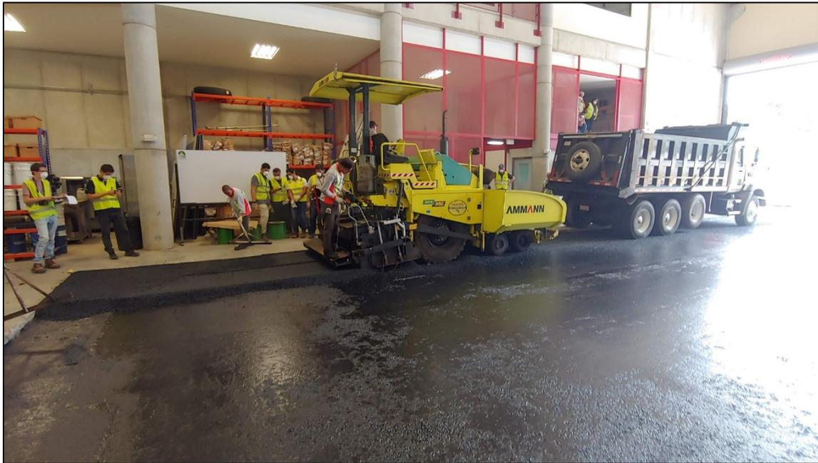
**Figura 36.** Continuación del proceso de colocación de mezcla asfáltica.
