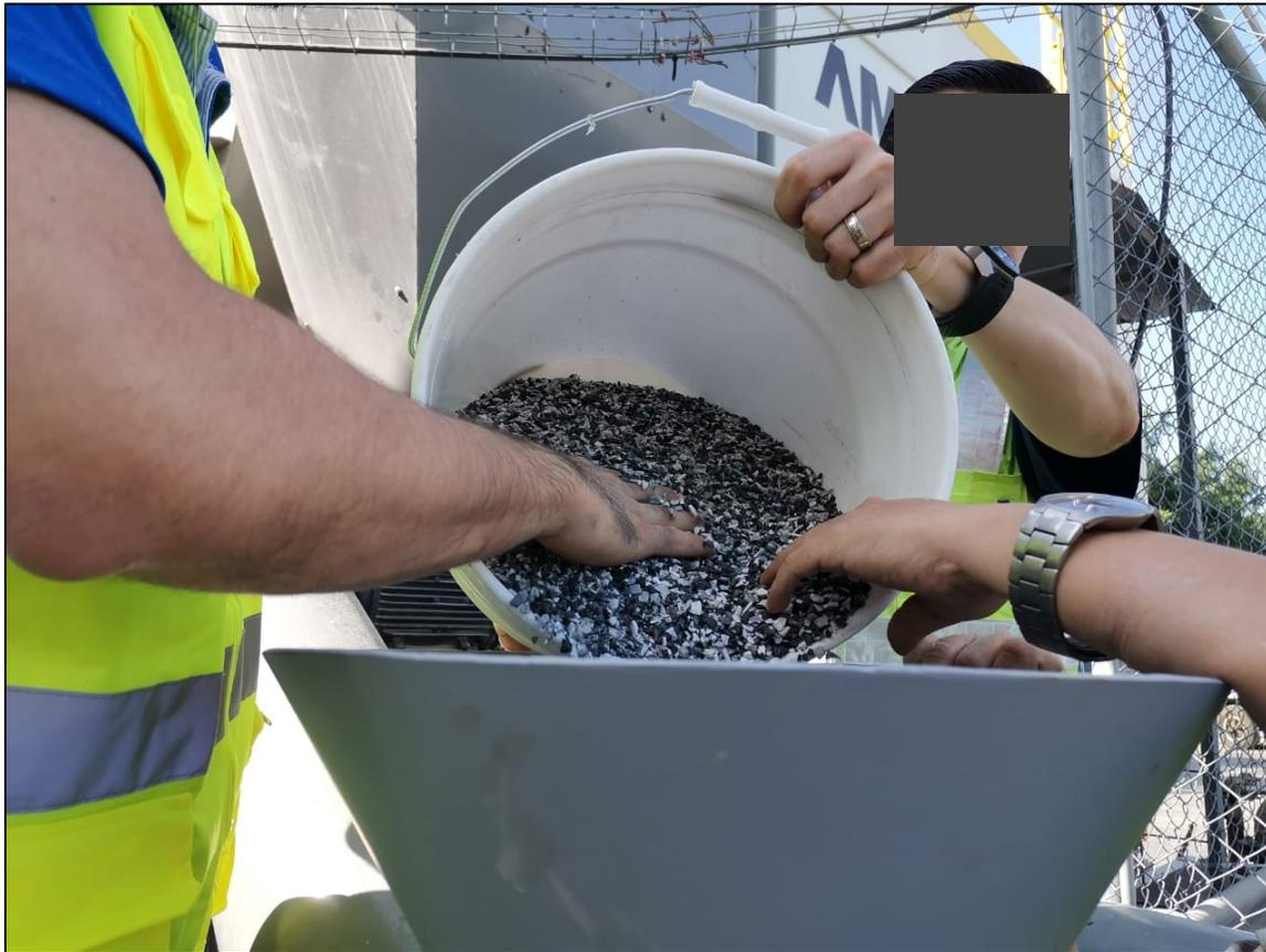
**Figura 28.** Ingreso del material en la tubería designada para la planta mezcladora.
