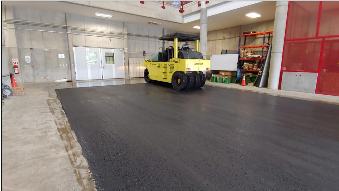
**Figura 41.** Proceso de acabo final con el compactador de llanta de hule.
