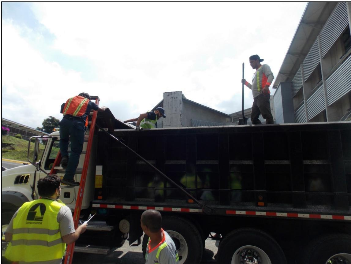
**Figura 32.** Muestreo de mezcla asfáltica en las vagonetas.
