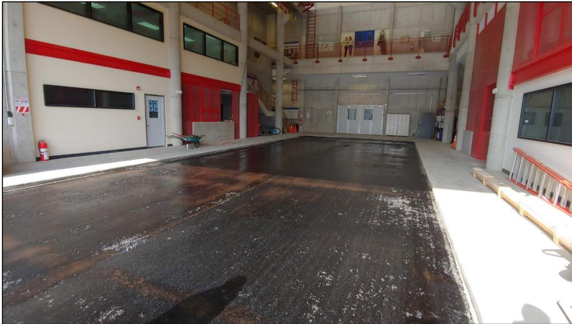
**Figura 31.** Proceso de riego de liga finalizado.
