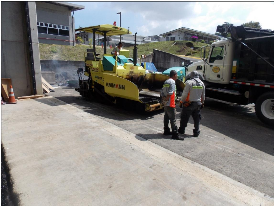
**Figura 34.** Pavimentadora utilizada en la construcción.
