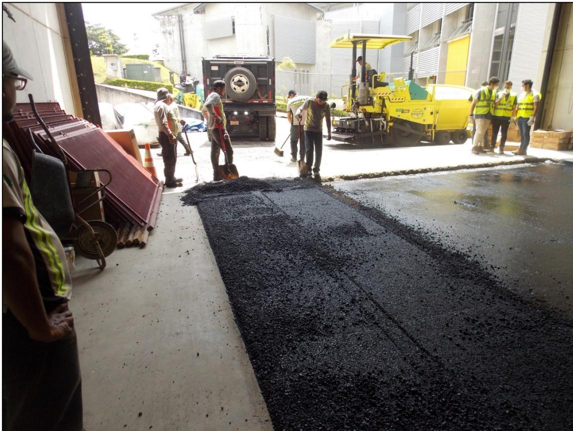
**Figura 37.** Finalización de la colocación de mezcla asfáltica de un tramo experimental.
