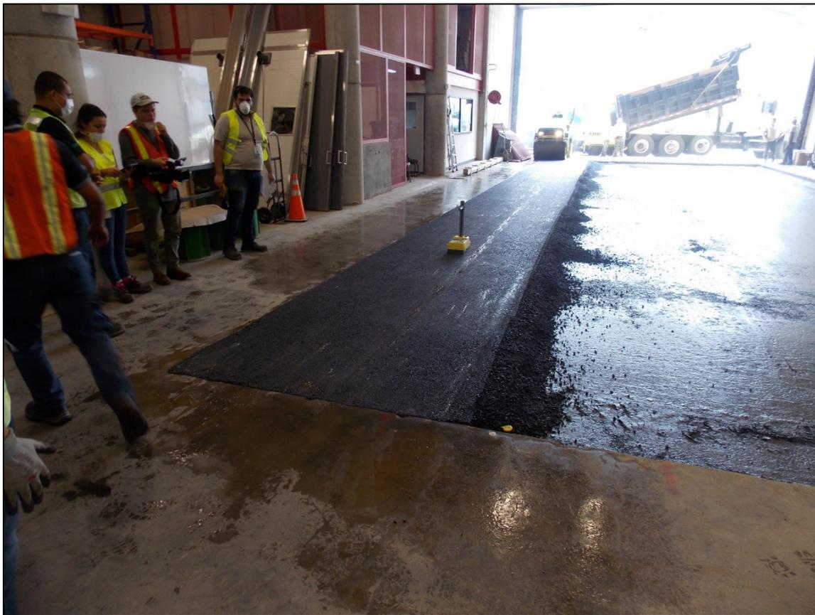
**Figura 39.** Verificación de porcentaje de vacíos con el densímetro nuclear.
