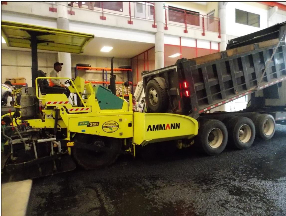
**Figura 35.** Proceso de colocación de mezcla asfáltica con vagoneta y pavimentadora.
