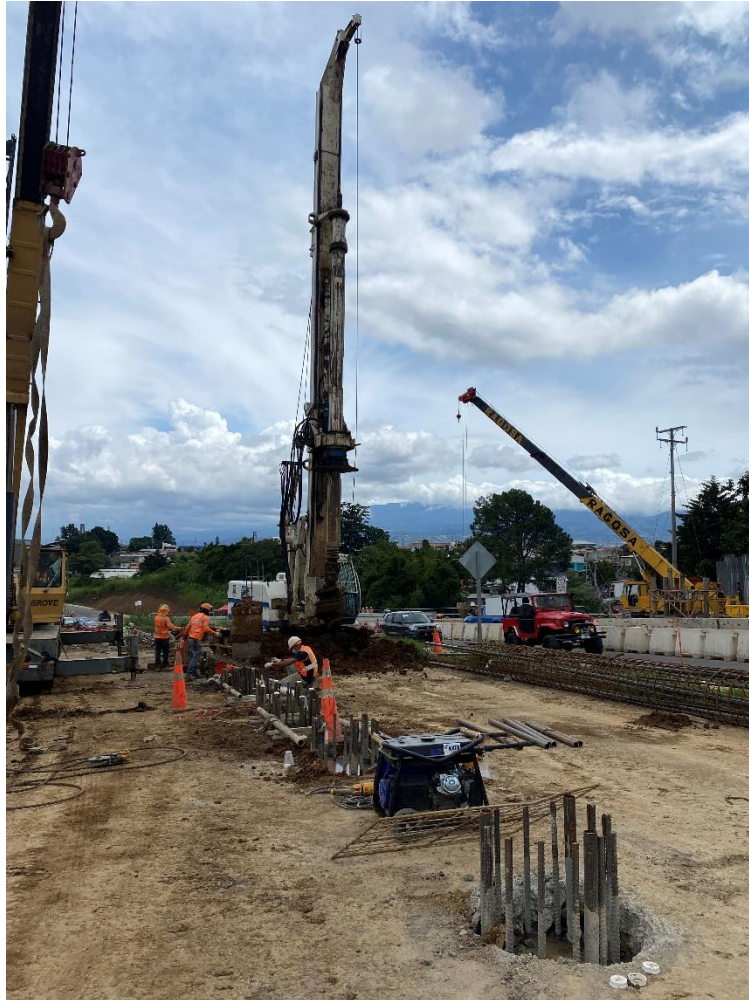
Fotografía 4. Configuración de pilotes preexcavados del MP Eje 7
