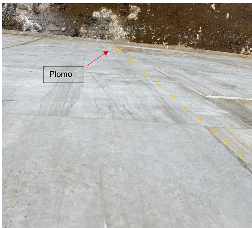
Fotografía 1. Verificación de verticalidad con plomo
