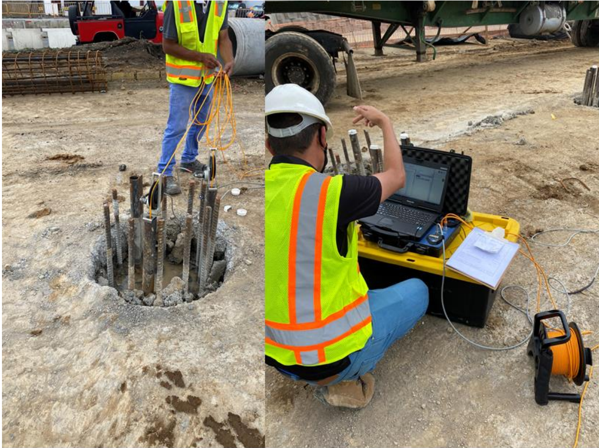
Fotografía 5. Ejecución de ensayos de integridad a pilotes de Eje 7
