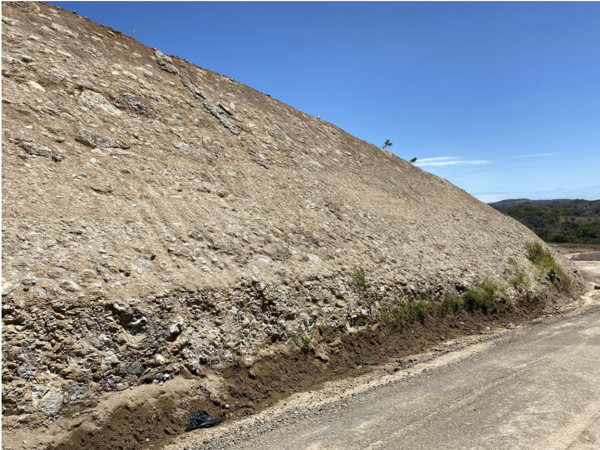
Fotografía 6. Talud de mediana altura a margen izquierda, sentido Cañas - Limonal
