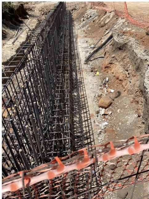
Fotografía 8. Colocado del acero de refuerzo para viga de amarre en Intercambio Limonal
