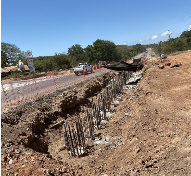
Fotografía 7. Pilotes finalizados en intercambio Limonal al lado derecho, sentido Limonal - Cañas
