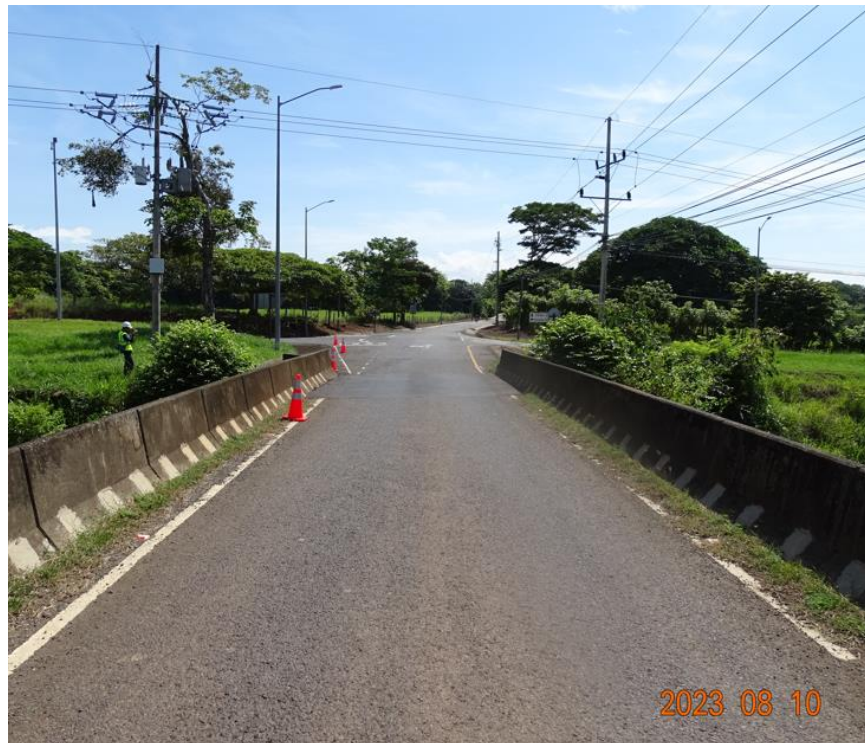
Figura 4.2. Vista a lo largo de la línea de centro del puente (hacia La Ceiba, Orotina).
