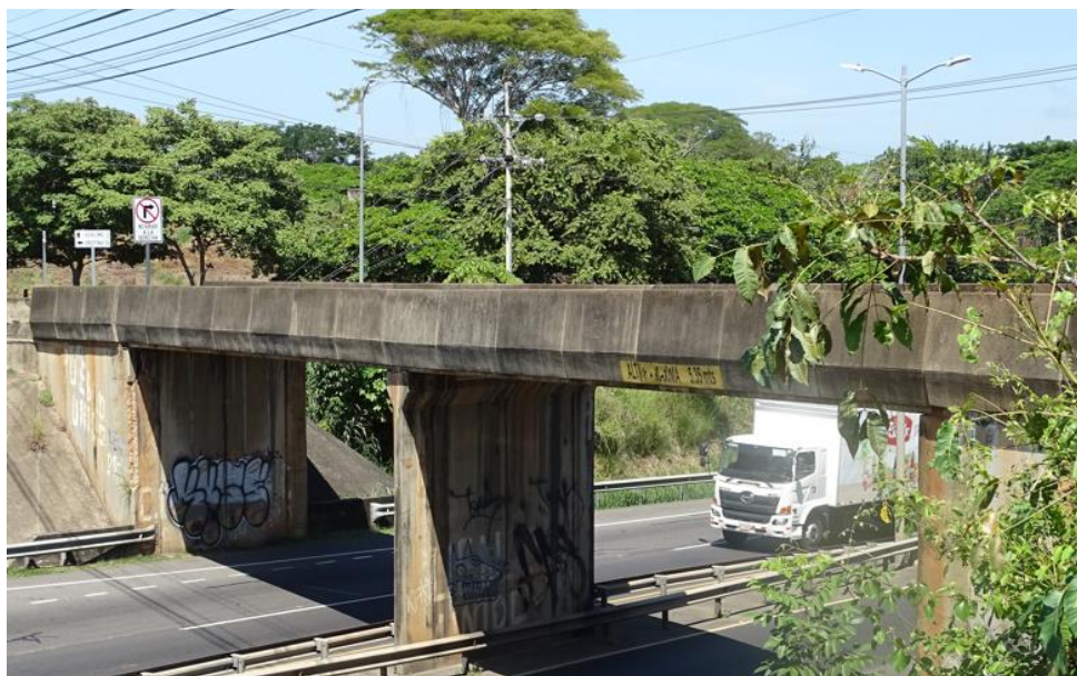
Figura 4.3. Vista lateral del costado este del puente
