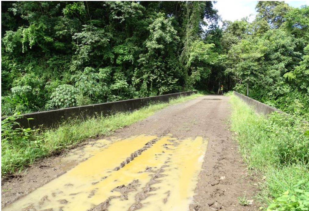
Figura 4.2. Vista a lo largo de la línea de centro del puente hacia Las Palmas
