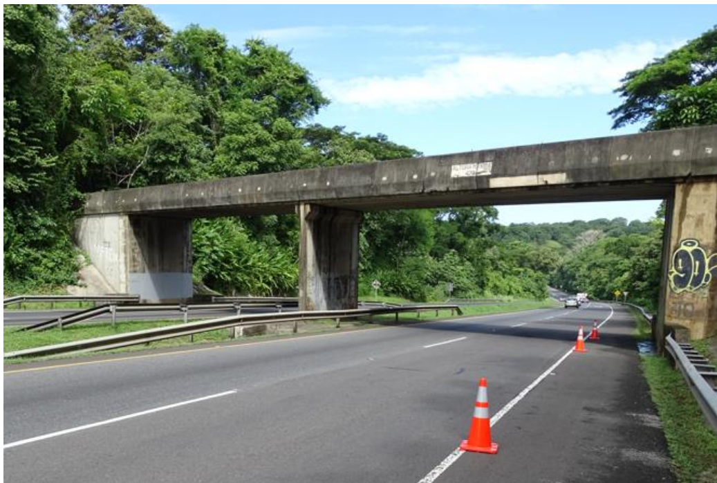
Figura 4.3. Vista lateral del costado oeste del puente
