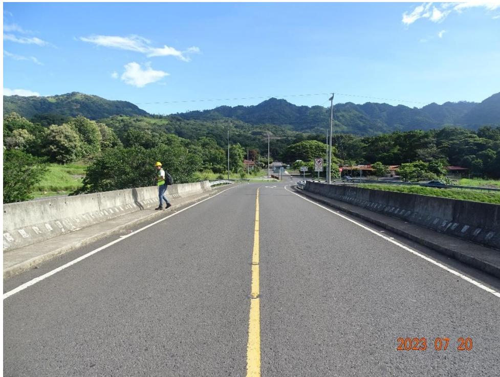
Figura 4.2. Vista a lo largo de la línea de centro del puente hacia Escobal
