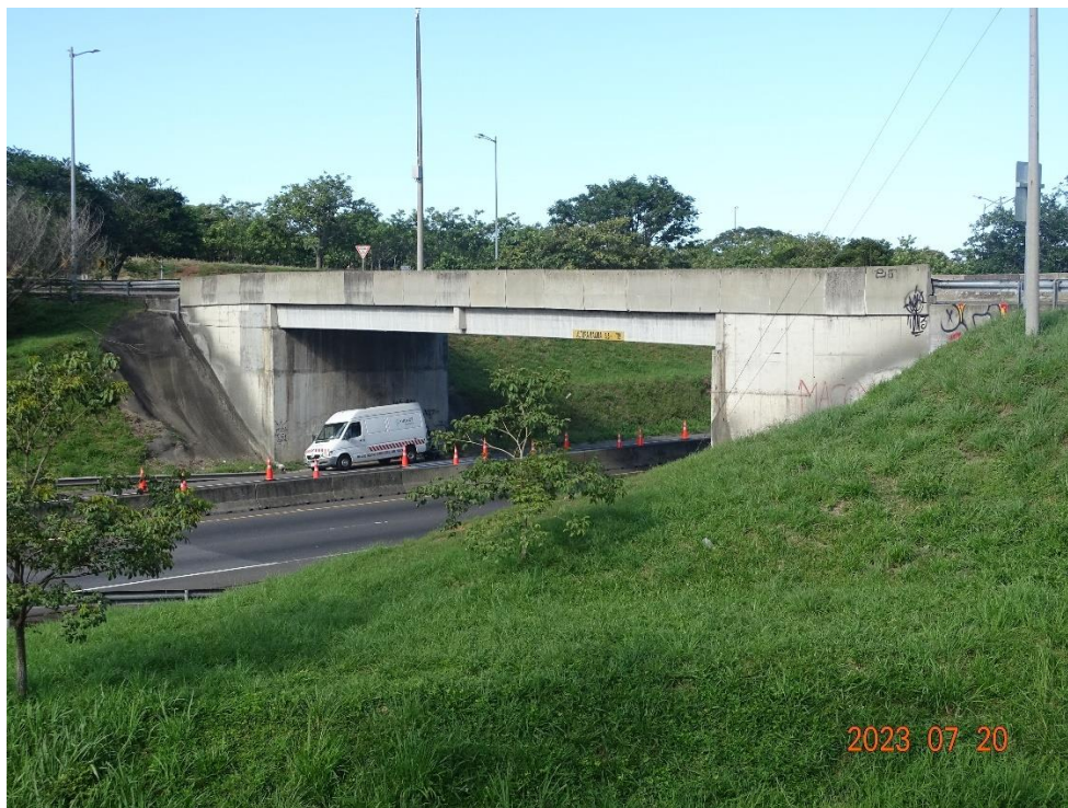
Figura 4.3. Vista lateral del costado este del puente
