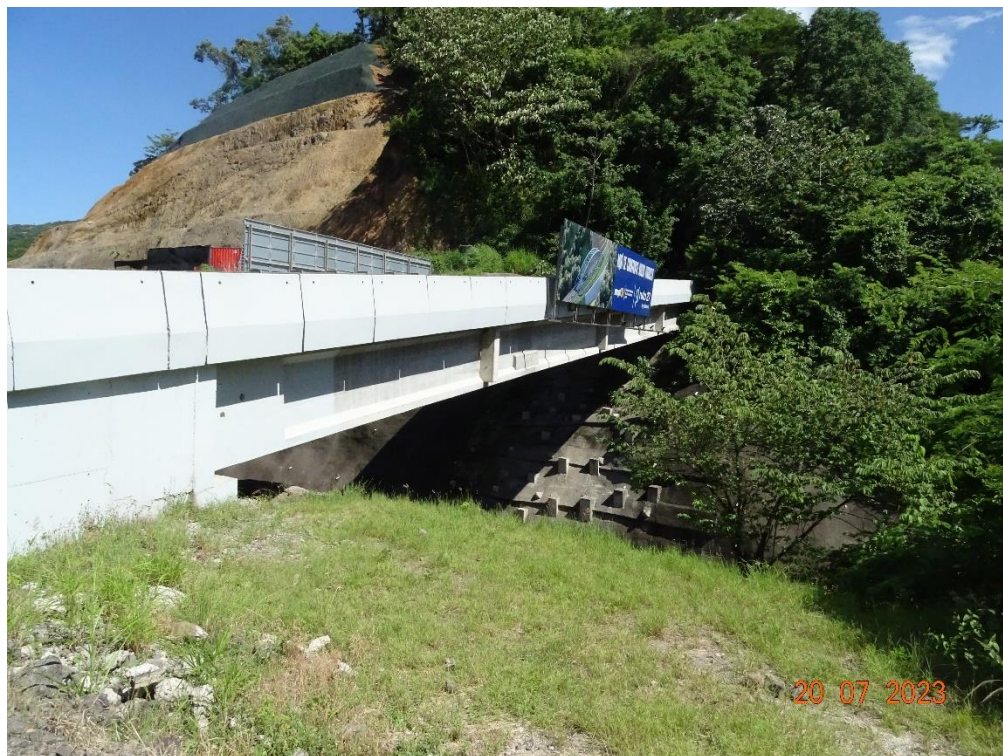
Figura 4.3. Vista lateral del costado este del puente
