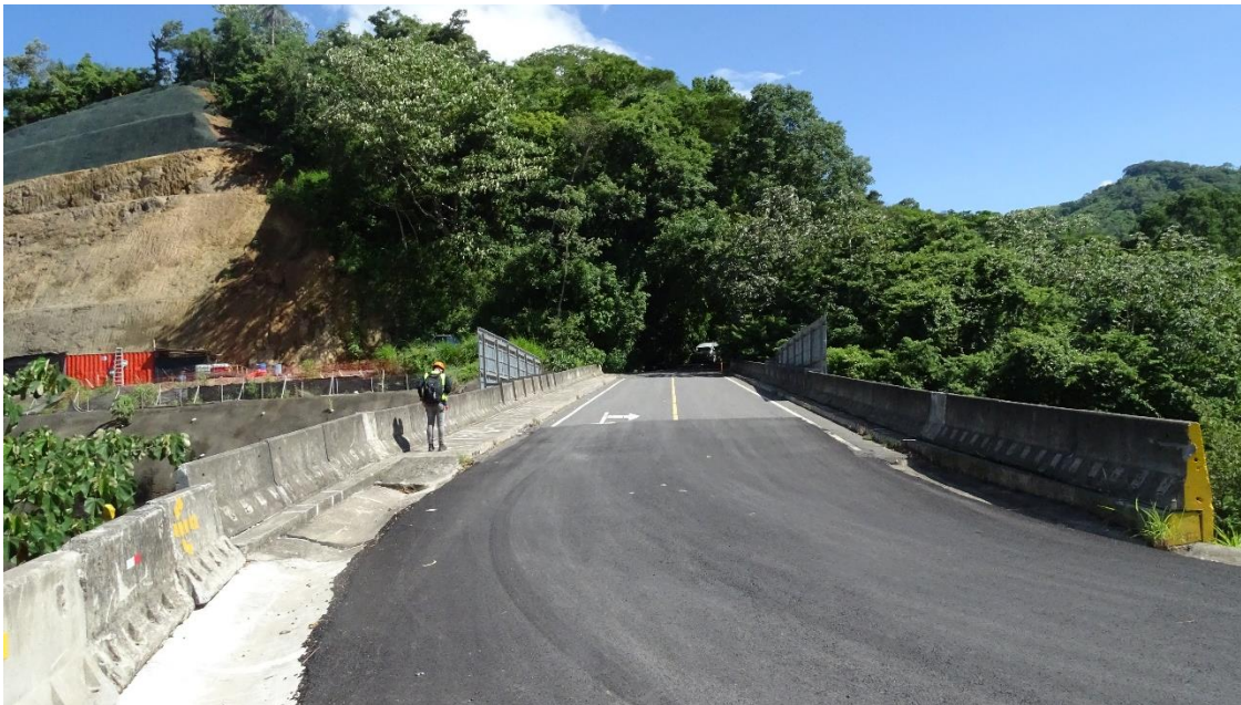
Figura 4.2. Vista a lo largo de la línea de centro del puente hacia Escobal
