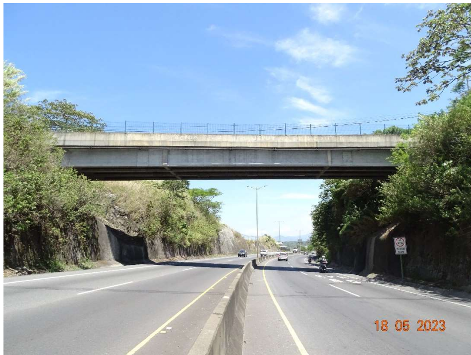
Figura 4.3. Vista lateral del costado este del puente
