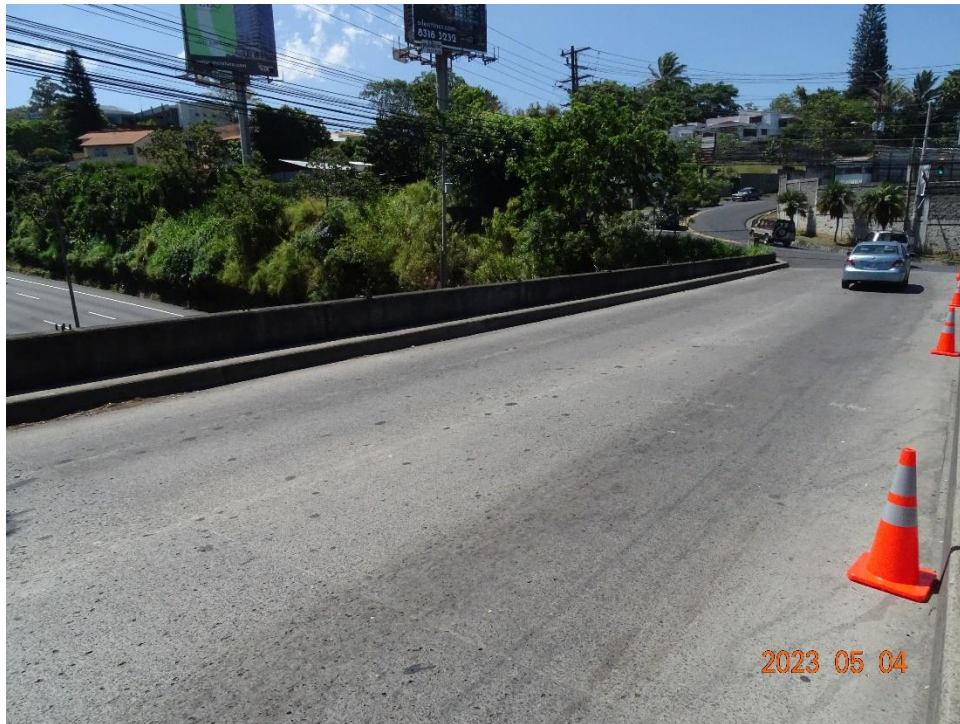
Figura 4.2. Vista a lo largo de la línea de centro del puente hacia Escazú
