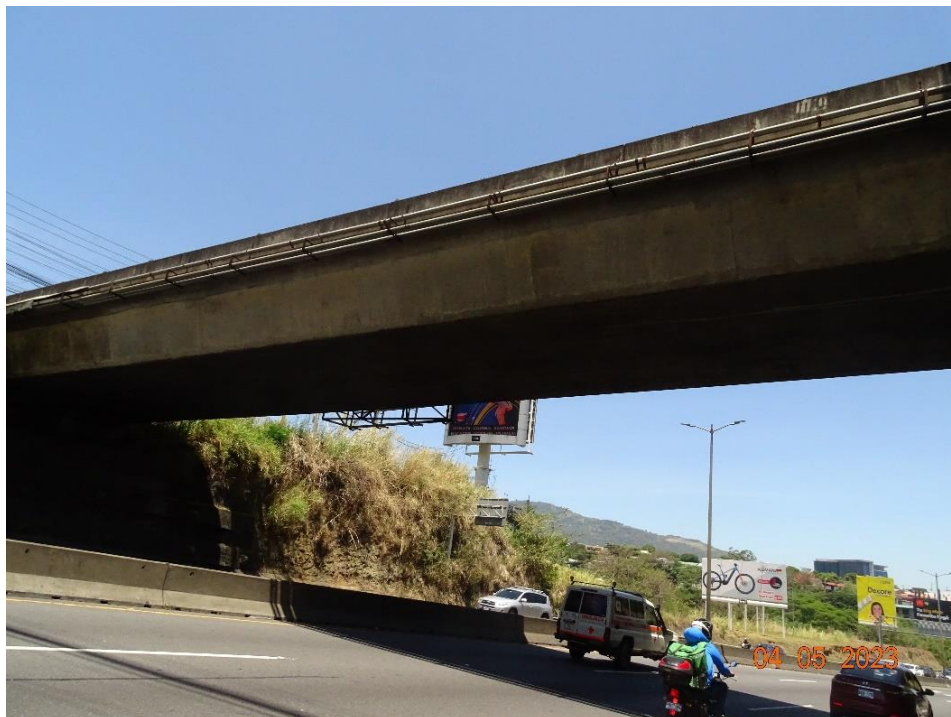
Figura 4.3. Vista lateral del costado este del puente
