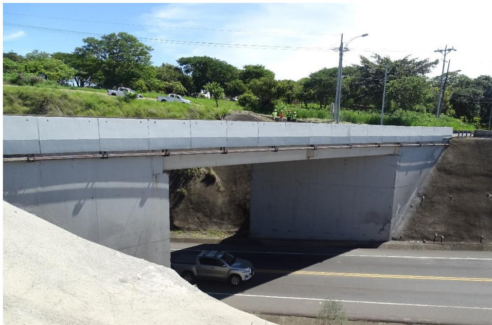
Figura 4.3. Vista lateral del costado este del puente
