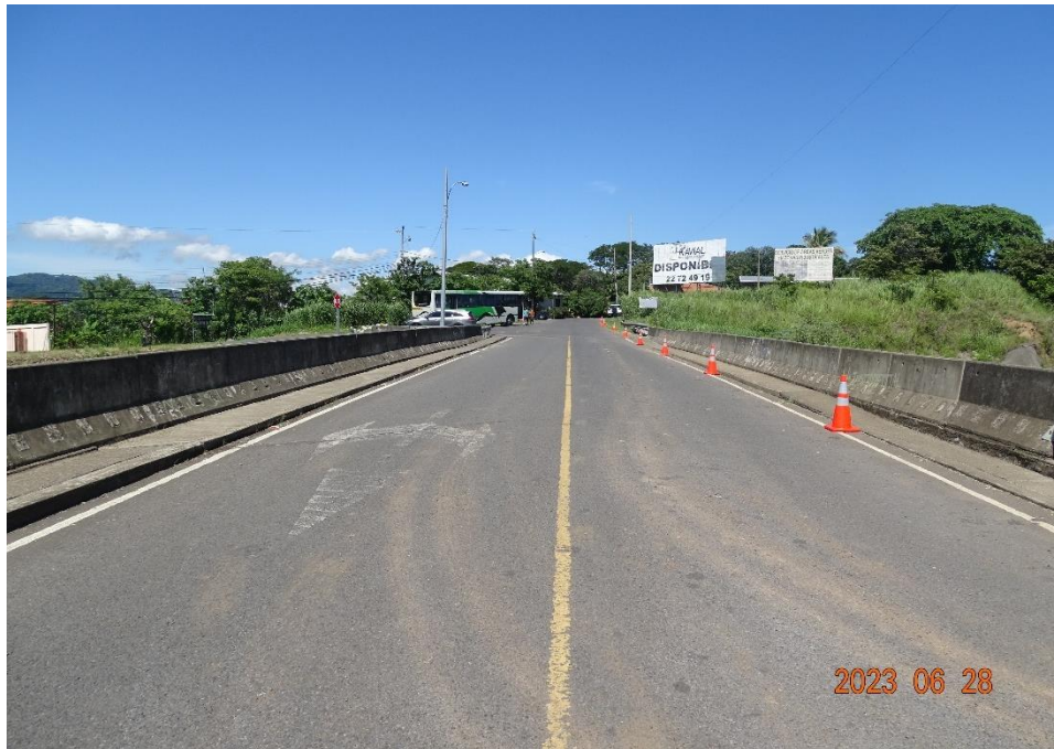
Figura 4.2. Vista a lo largo de la línea de centro del puente hacia carril sector de La Guácima
