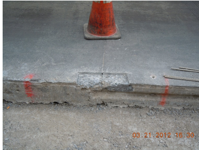
Figura 11. Bacheo a espesor parcial realizado. Ubicación: ruta nacional 2, km 18+700. Sección de control 30730, Lte. Cant. La Unión/Cartago - Taras. Fecha: 21 de marzo de 2012. Fuente: LanammeUCR
