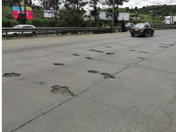
Figura 9. Condición severa de deterioro de juntas en Ruta Nacional 2, Sección de control 30730 (Límite Cantonal La Unión / Cartago (Quebrada Quirazú) - Taras (Ruta 236)). Estacionamiento 18+690. Fecha 15 de junio de 2022. Fuente: LanammeUCR
