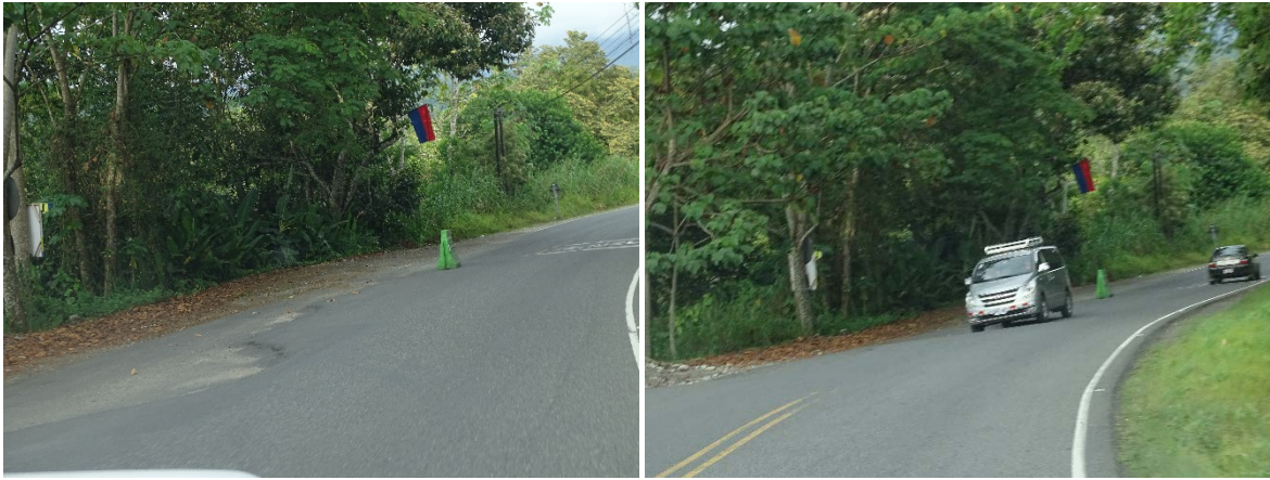
Figura 28. Hundimiento sobre la carretera. Ruta Nacional 2, Sección de control 60012 (Límite Cantonal Osa/Golfito – Río Claro) Estacionamiento 316+163. Fecha 17 de febrero de 2022. Fuente: LanammeUCR
