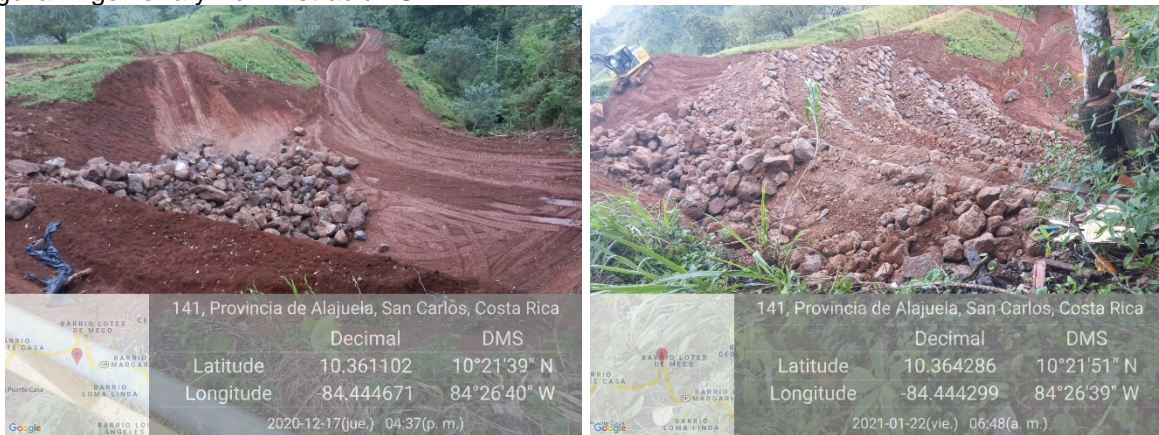
Figura 36. Construcción del sistema de banqueo. Ruta Nacional 141, Sección de control 20630 (Ciudad Quesada R140 – Florencia R35) Estacionamiento 54+735. Fecha 24 de marzo de 2022. Fuente: Ileana Aguilar Ingeniería y Administración S.A.
