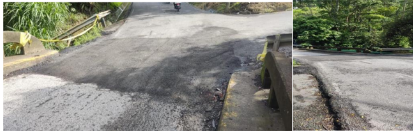
Fotografía 1. Atención de Accesos a Puente sobre Río Ipís.
