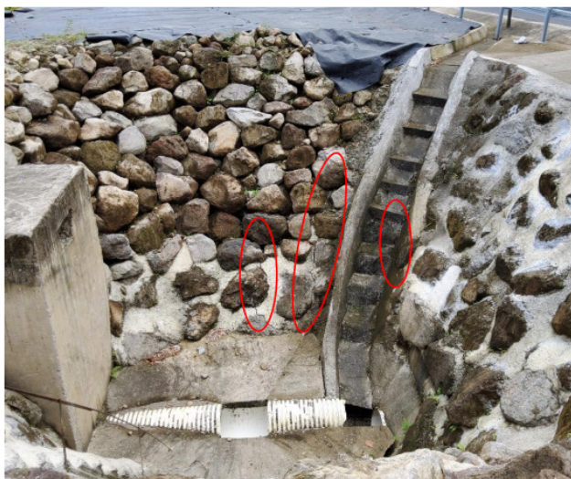
Figura 9 Condición actual de la estructura de contención y registro de aguas
