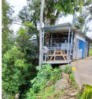
Figura 3 Vivienda ubicada en la corona del talud
