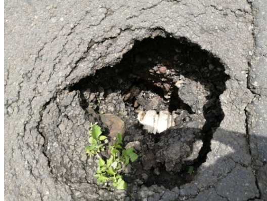
Figura 14. Hundimiento de mezcla asfáltica Ruta Nacional 117, Sección de control 19035 (El Límite (RN102) – Límite Provincial San José/Heredia (Río Virilla)) Estacionamiento 24+290. Fecha 11 de mayo de 2022. Fuente: LanammeUCR
