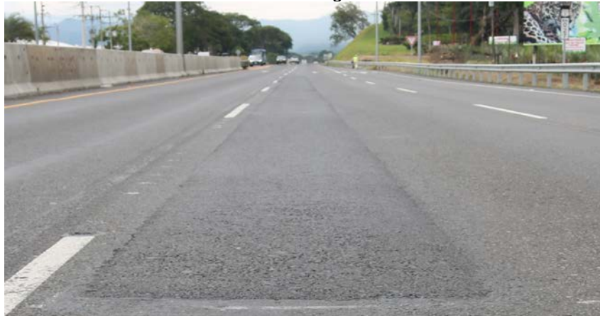
Figura 53. Bacheo mezcla asfáltica en capa de rueda inicio carril central de las Obras de Ampliación Río Alajuela, sentido San José-San Ramón. Fecha 22 de agosto de 2022
