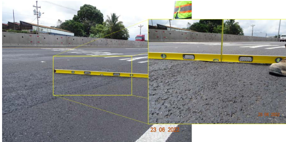
Figura 66. Irregularidad en superficie superior a 1 cm por el borrado de demarcación. Fecha: 23 de junio del 2022
