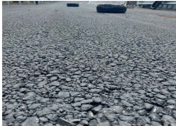
Figura 60. Segregación en carril de rampa de salida hacia RN No.1. Fecha: 07 de mayo del 2021
