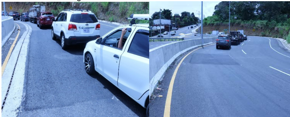
Figura 51. Bacheos mezcla asfáltica en capa de ruedo del carril interno del tronco principal del Conector Barreal-Castella. Fecha 22 de agosto de 2022
