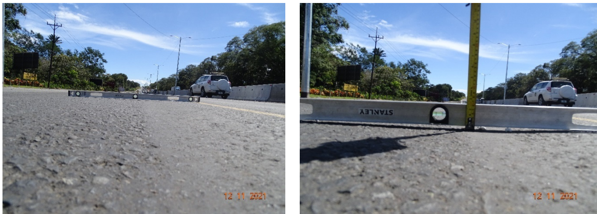
Figura 58. Diferencias de nivel entre juntas puente sobre el río Alajuela. Fecha: 12 de noviembre del 2021
