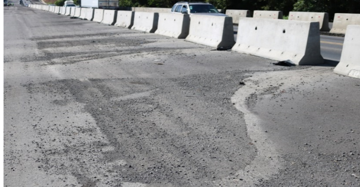
Figura 18. Secciones de la ruta donde se habían identificado deformaciones cubiertas de polvo y arena. Fecha: 2 de julio del 2021
