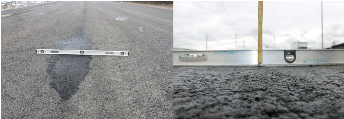
Figura 58. Diferencias de nivel entre juntas puente sobre el río Alajuela. Fecha: 12 de noviembre del 2021
