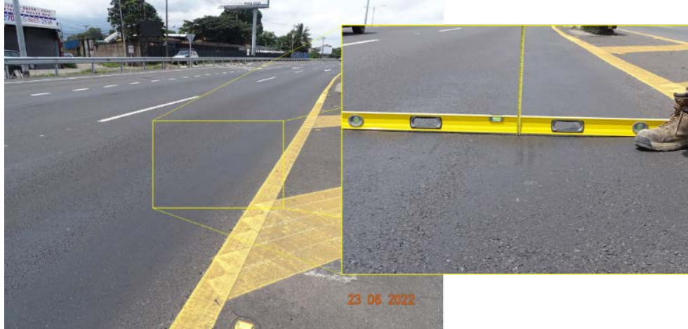
Figura 48. Deformación superior a 1 cm carril central sentido San Ramón – San José, Puente sobre el río Ciruelas. Fecha: 23 de junio del 2022
