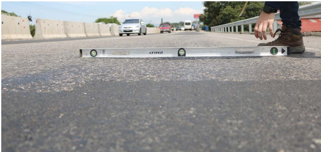
Figura 7. Deformación de zonas cercanas a bacheos realizados. Fecha: 2 de julio del 2021
