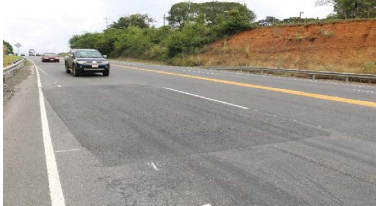
Figura 53. Bacheo mezcla asfáltica en capa de rueda inicio carril central de las Obras de Ampliación Río Alajuela, sentido San José-San Ramón. Fecha 22 de agosto de 2022
