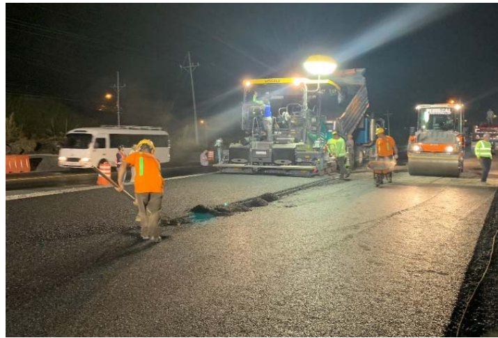
Figura 2. Colocación de mezcla asfáltica en proyecto río Ciruelas. Fecha: 15 de febrero del 2021
