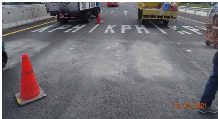
Figura 63. Condición de borrado en demarcación carriles del sentido San Ramón – San José. Fecha: 24 de setiembre del 2021
