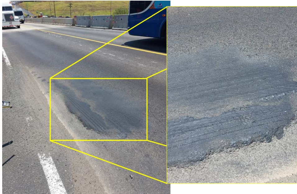
Figura 4. (a) Ahuellamiento de aproximadamente 4 cm (b) Ahuellamiento de aproximadamente 1 cm. Fecha: 18 de marzo del 2021
