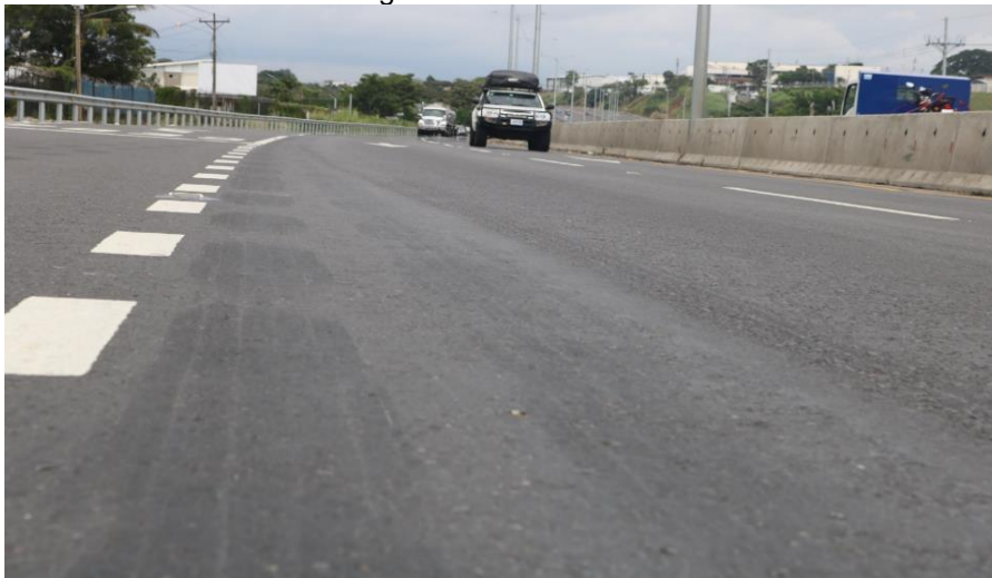
Figura 36. Exudación carril central en sentido San José-San Ramón cercanos a 18+770, Obras de ampliación del río Ciruelas. Fecha 22 de agosto de 2022
