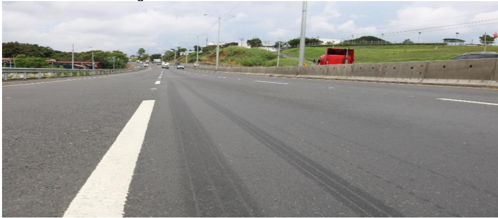
Figura 36. Exudación carril central en sentido San José-San Ramón cercanos a 18+770, Obras de ampliación del río Ciruelas. Fecha 22 de agosto de 2022
