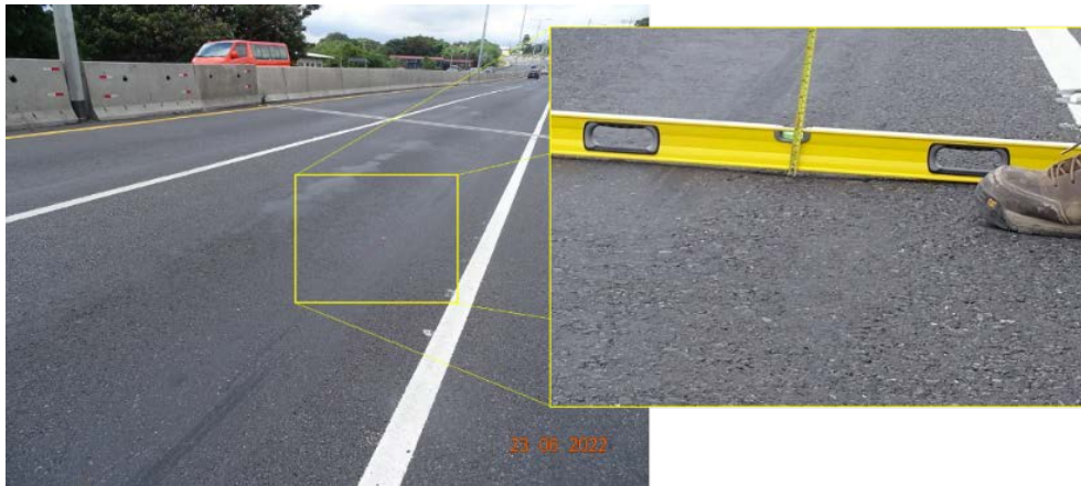
Figura 48. Deformación superior a 1 cm carril central sentido San Ramón – San José, Puente sobre el río Ciruelas. Fecha: 23 de junio del 2022
