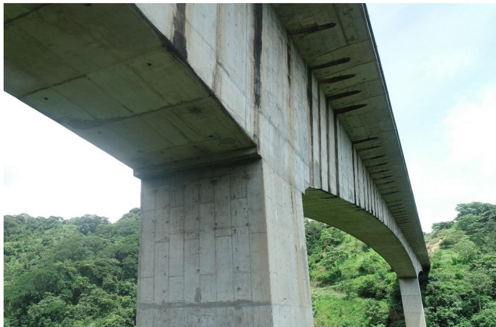
Figura 4.3. Vista lateral del costado aguas arriba del puente
