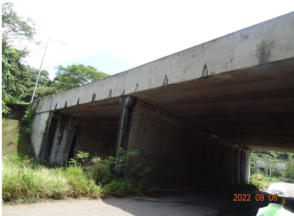
Figura 4.3. Vista lateral del costado norte del puente
