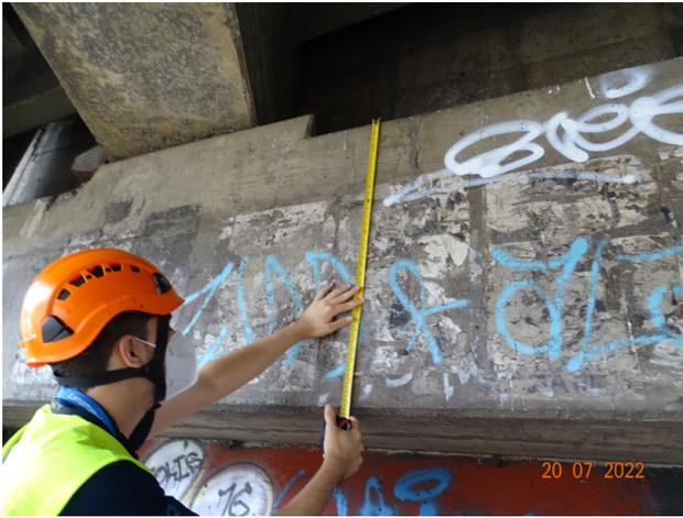
**Figura 4. Medición de dimensiones de elementos estructurales del puente sobre la RN 102 en la RN 32.**
