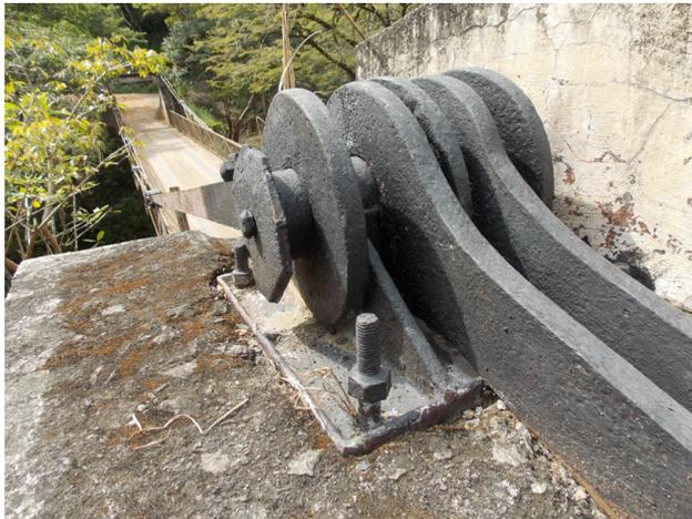
**Figura 7. Elemento crítico por fractura (tipo barra con agujero circular) del antiguo puente sobre el río Grande de Tárcoles en la RN707.**
