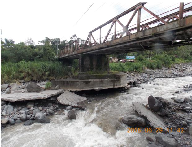
**Figura 2. Socavación de la cimentación del puente sobre el río Turrialba en la RN230**
