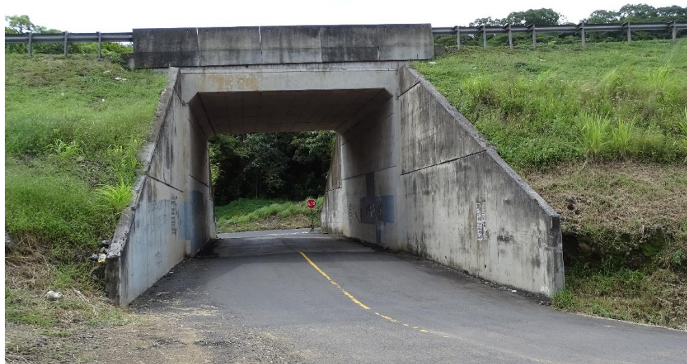
Figura 4.3. Vista lateral del puente en el costado sur
