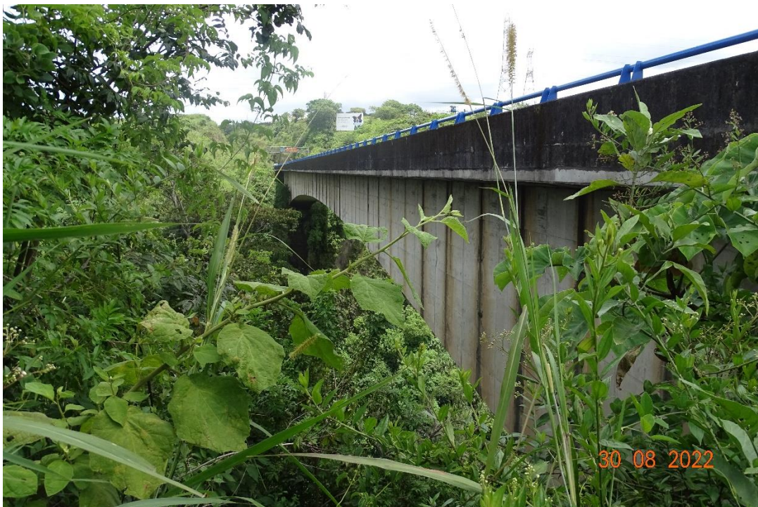
Figura 4.3. Vista lateral del costado aguas abajo del puente
