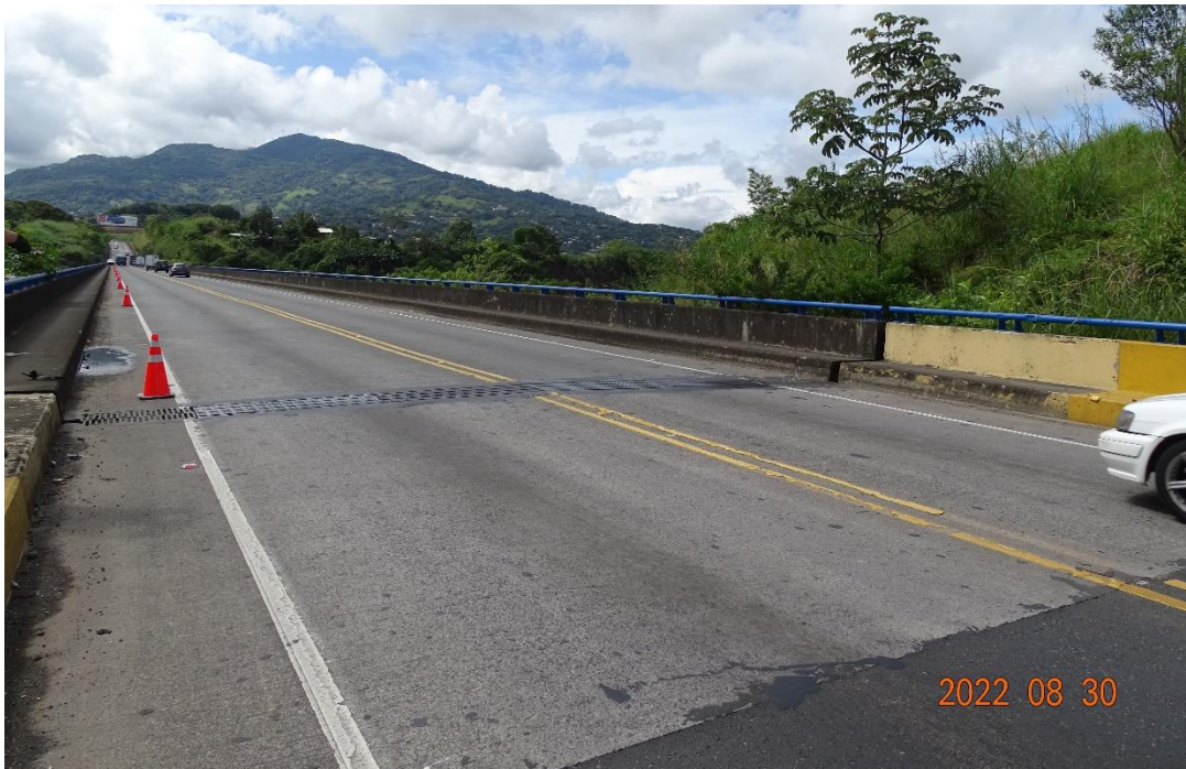
Figura 4.2. Vista a lo largo de la línea de centro del puente hacia San José
