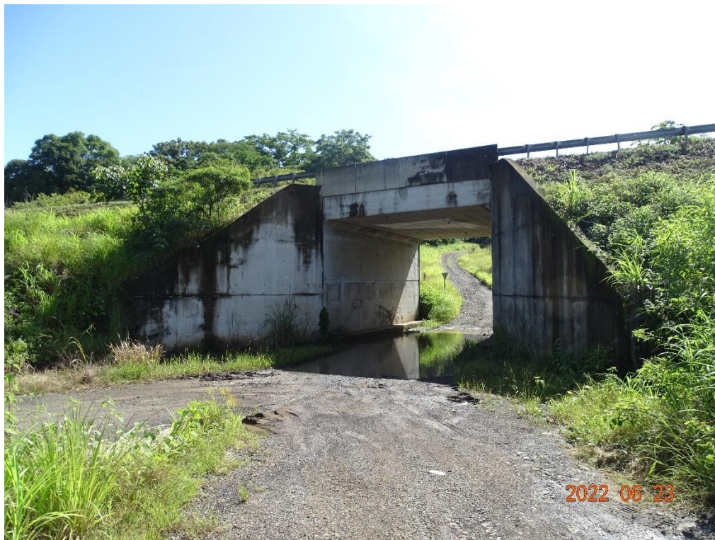
Figura 4.3. Vista lateral del costado suroeste del puente
