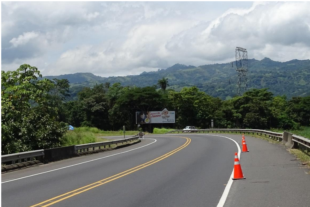
Figura 4.2. Vista a lo largo de la línea de centro del puente hacia San José
