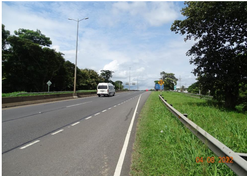
Figura 4.2. Vista a lo largo de la línea de centro del puente sentido Caldera-San José
