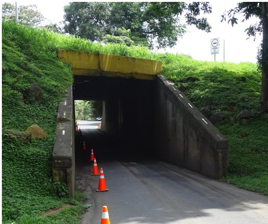
Figura 4.3. Vista lateral del costado noreste del puente (hacia Cascajal)
