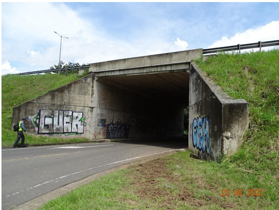
Figura 4.3. Vista lateral del costado norte del puente
