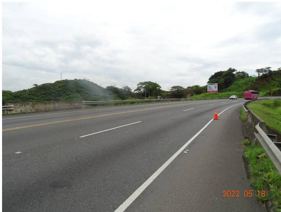
Figura 4.2. Vista a lo largo de la línea de centro del puente hacia Orotina
