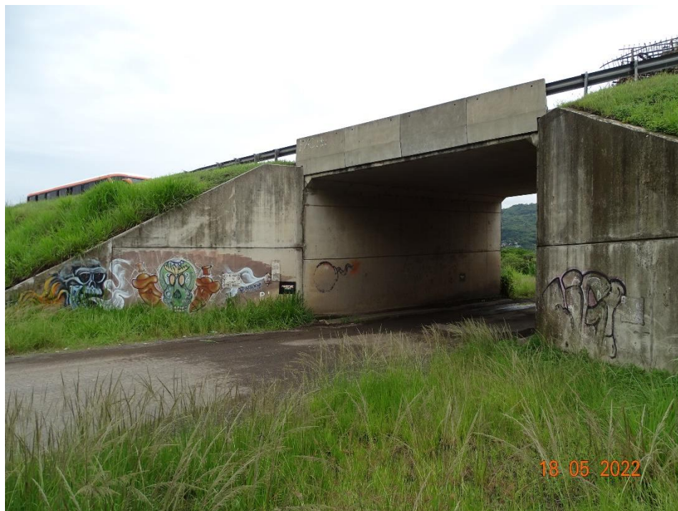
Figura 4.3. Vista lateral del costado sureste del puente
