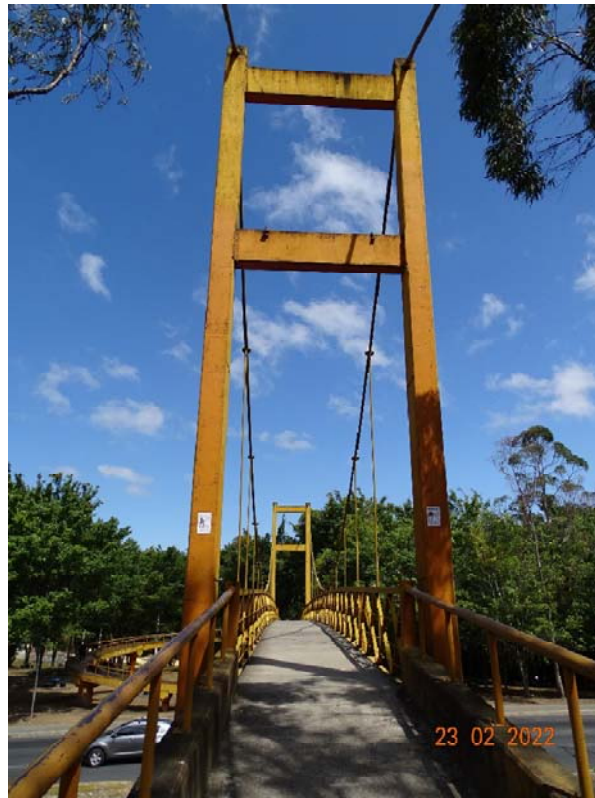
Figura 4.2. Vista a lo largo de la línea de centro del puente peatonal hacia el norte
