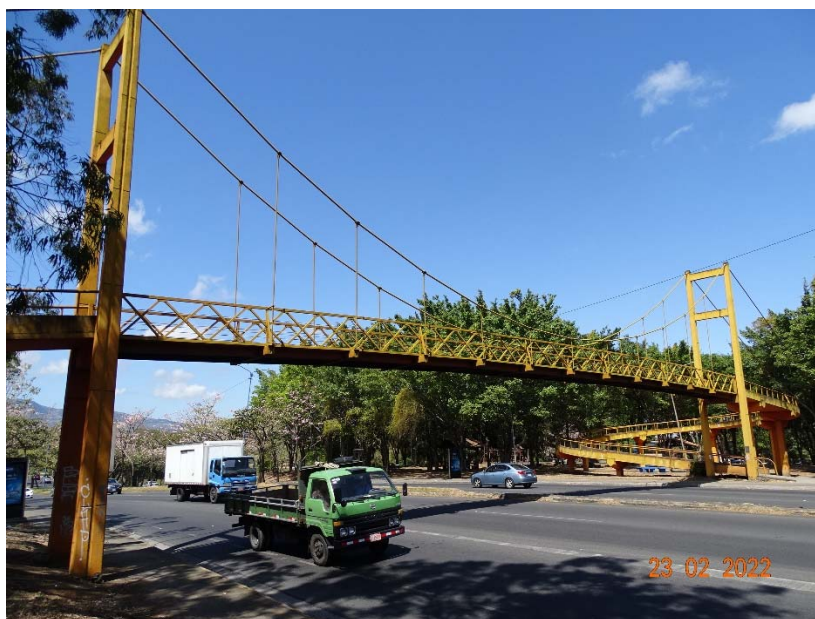
Figura 4.3. Vista lateral del costado este del puente peatonal
