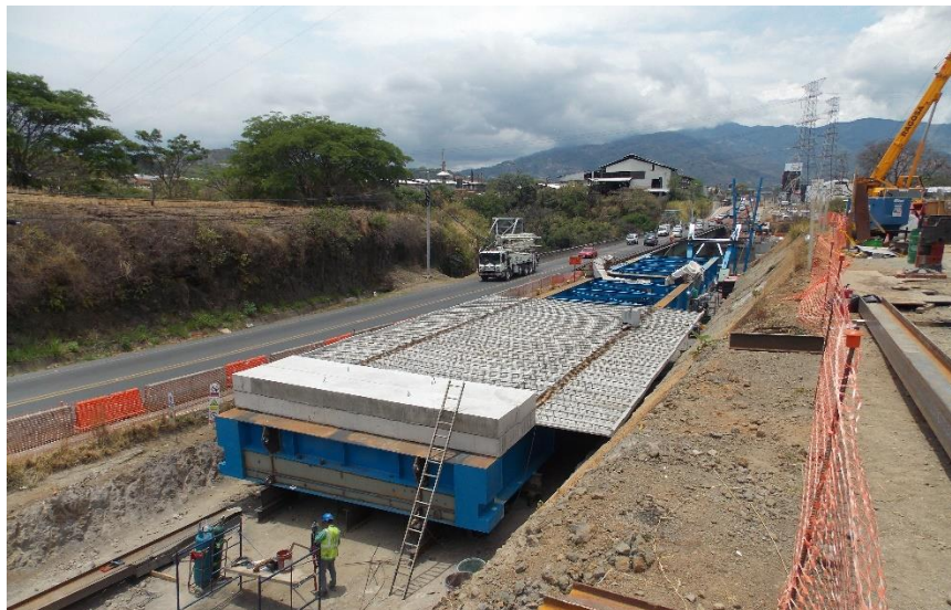
Puente sobre Rio Virilla – Ruta Nacional 147
