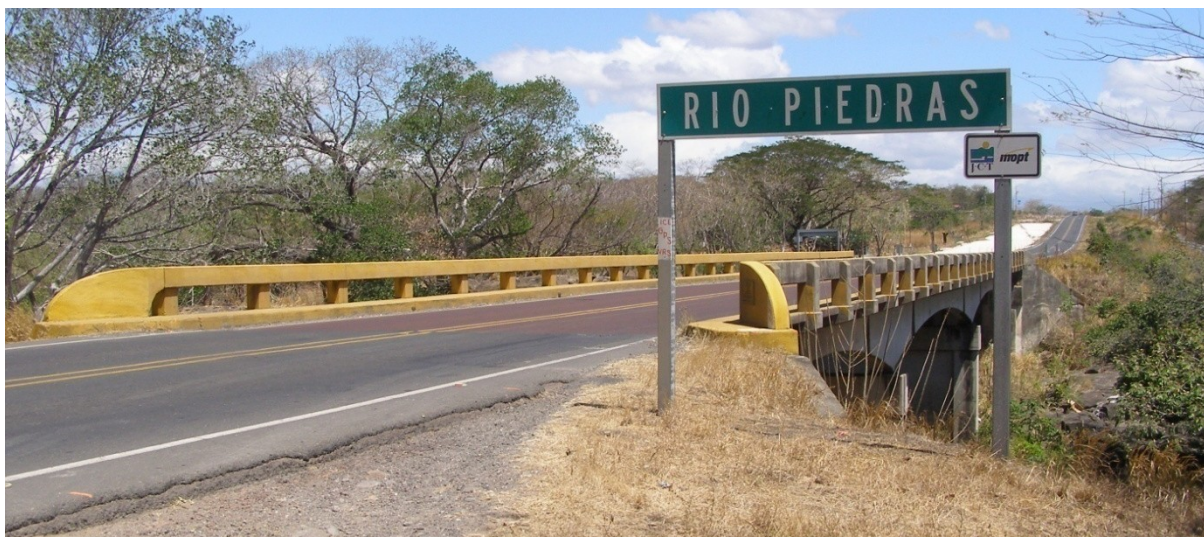
Figura 2: Vista a lo largo de la línea de centro del puente sobre el Río Piedras.
