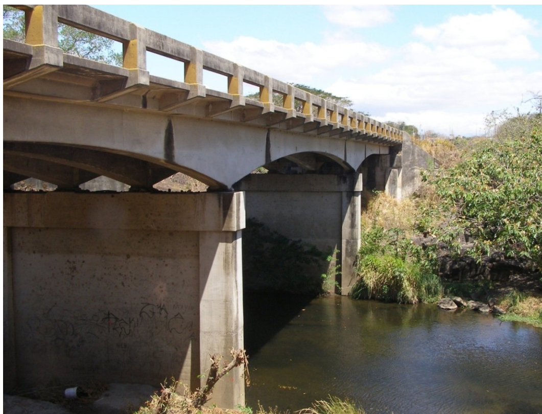
Figura 3: Vista lateral del puente sobre el Río Piedras.
